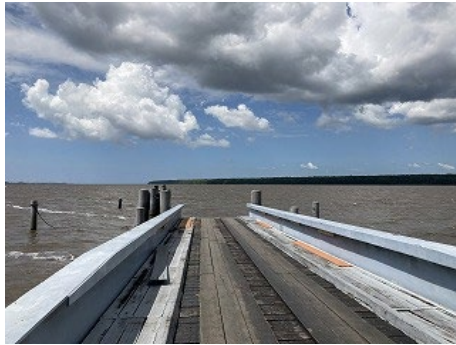
注：写真に写っている対岸は中洲の Vassen 島 撮影：調査団
