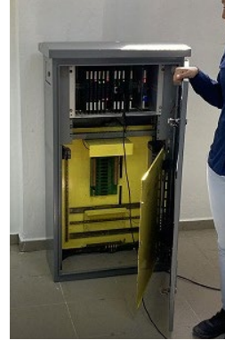
図 5-25 遠隔制御されている信号機とその制御機器
