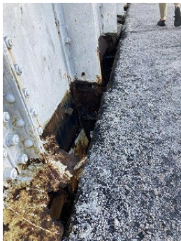
図 5-9 Swing 橋の鋼材の腐食
