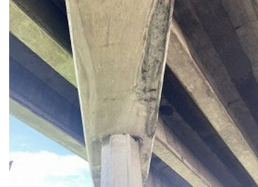
図 5-21 国道 3 号線にかかる跨道橋（左）と劣化箇所（中央・右）
