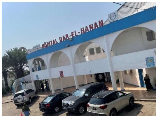
ダル・エル・ハナン産科病院正面 ジブチ国における産科のトップレファラル病院であり、多くの分娩を受け入れている。
