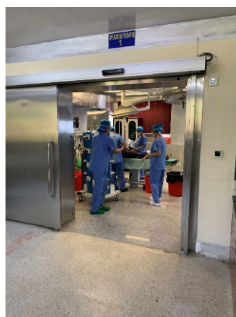
写真 10 病院本棟内の手術室。ステンレス製の自動扉が採用されている。
