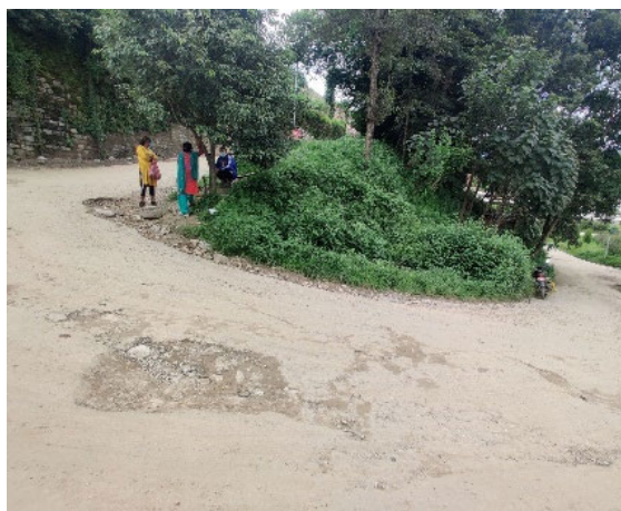
写真 21 候補地 B へのアクセス道路は急勾配かつ急カーブが連続する道路となっている。
