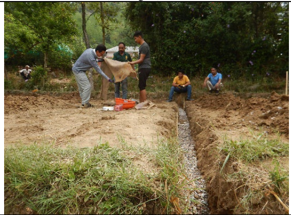
地下排水の設置 (Ragloo, Kangra, 2022年4月)
