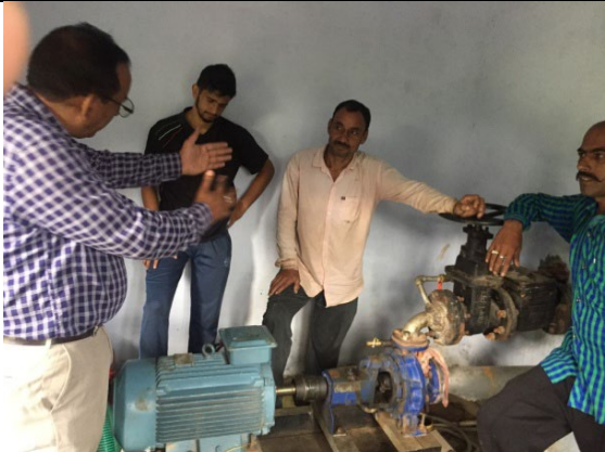
モニタリング（モータポンプの運転研修） (Sarkaghat, 2019年9月)
