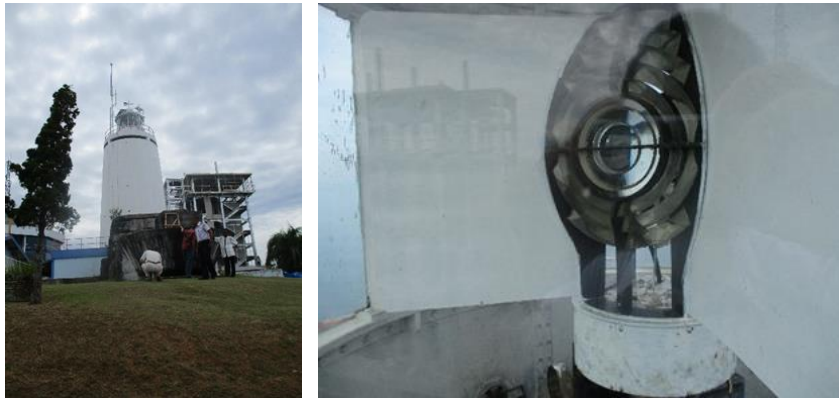
Gambar 4.1.13 -6 : Struktur Mercusuar, Bagian Lensa
