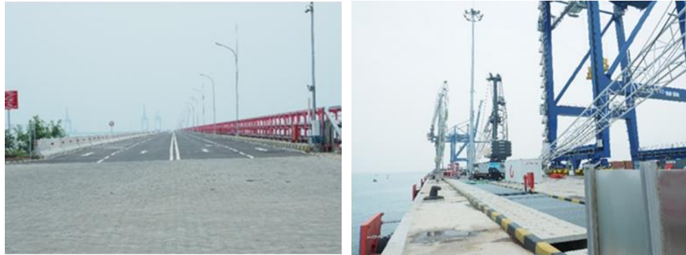
Gambar 4.1.8 -5 : Jetty sepanjang 2.8 km, Berth sepanjang 500 m
