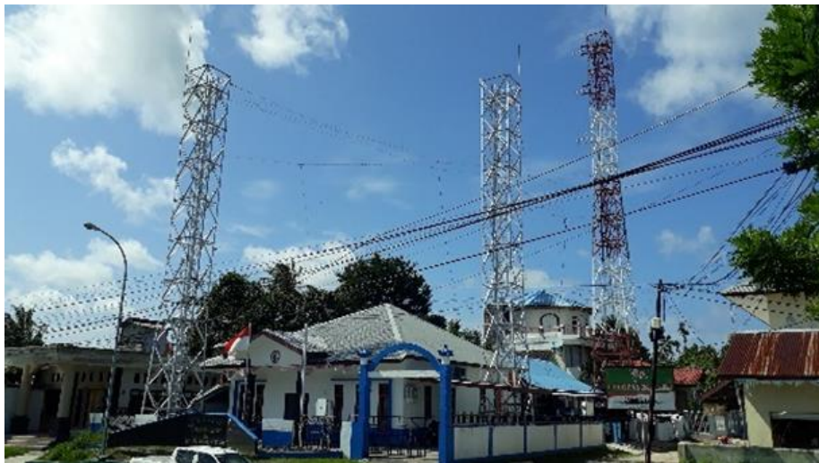
Gambar 4.1.3 -2 : Stasiun Radio Pantai
