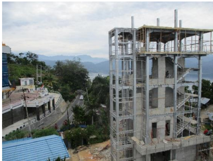
Gambar 4.1.13 -7 : Konstruksi bangunan baru
