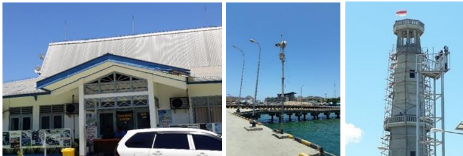
Gambar 4.1.14 -7 : Kantor UPP, Dermaga Pelabuhan, Mercusuar (Dalam pembangunan)
