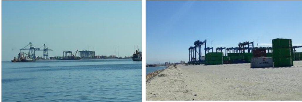
Gambar 4.1.7 -4 : Gantry Crane, Area Penyimpanan Kontainer
