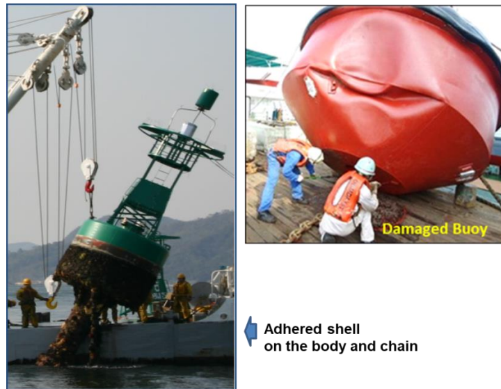
Gambar 6.7.1 -2 : Pemeliharaan Pelampung apung
