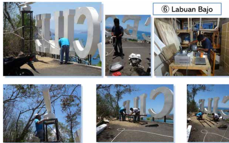
第 5.6 -1 写真 レーダー装置設置状況
