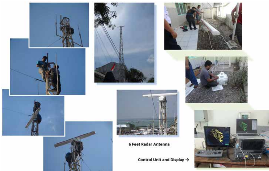
第5 -3 写真 レーダー空中線設置状況
