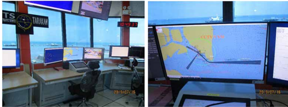
第4.1.6 -1 写真 VTS 運用室 (左) 及び AIS 運用卓 (右)
