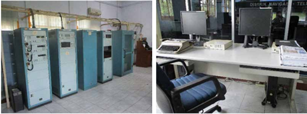
第 4.1.13 -5 写真 MF/HF, VHF 送受信及び GMDSS 運用卓
