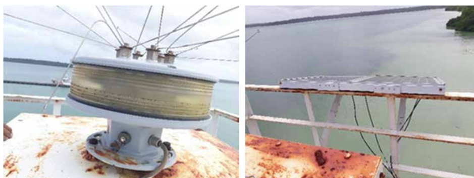
第 4.1.3 -5 写真 SAVIK 製 LED 灯器及び太陽光パネル
