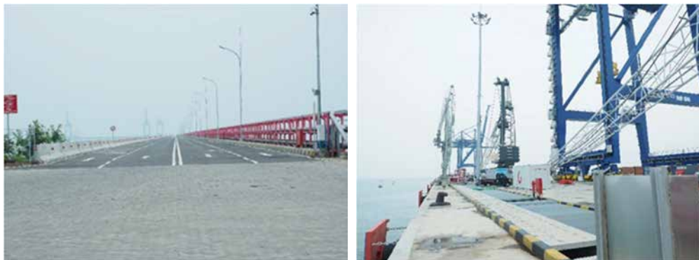
第 4.1.8 -6 写真 2.8km 長栈橋 及び 500m 長バース
