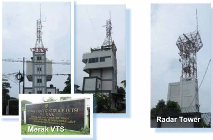
第 5.9 -1 写真 VTS 局舎及びレーダー局
