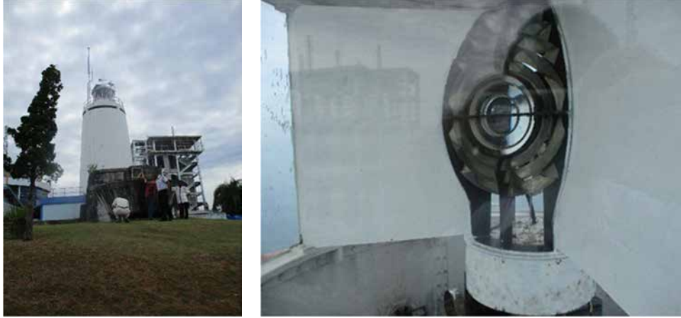
第 4. 1. 13 -6 写真 灯台外観およびレンズ部
