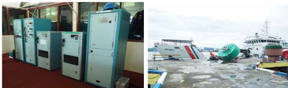
第 4.1.9 -3 写真 GMDSS 送受信機 (左) 及び設標船 (右)
