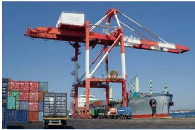
第 4.1.1 -1 写真 クパン港のコンテナヤード
