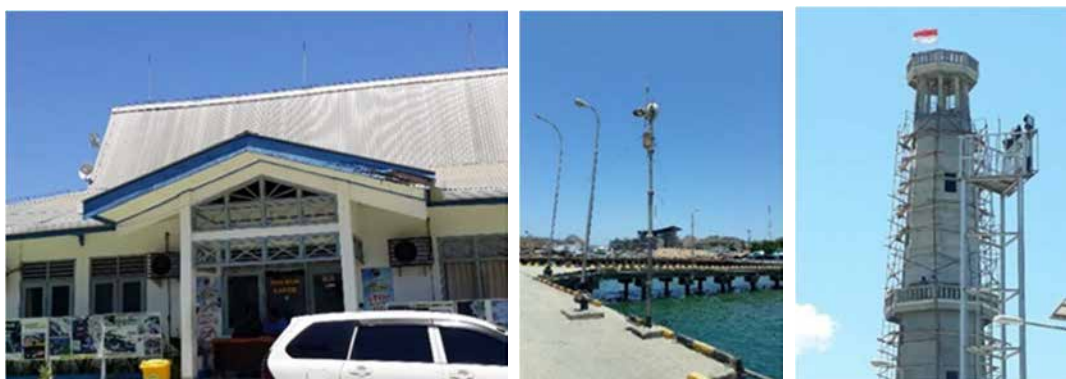
第 4.1.14 -7 写真 UPP 事務所、栈橋、建設中灯台
