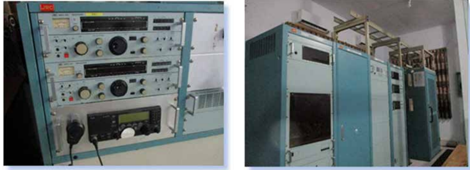
第 4.1.2 -2 写真 中波/短波機器及び空中線結合器
