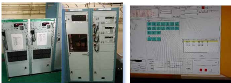
第 4.1.3 -3 写真 短波送信機及び GMDSS (表示画面)
