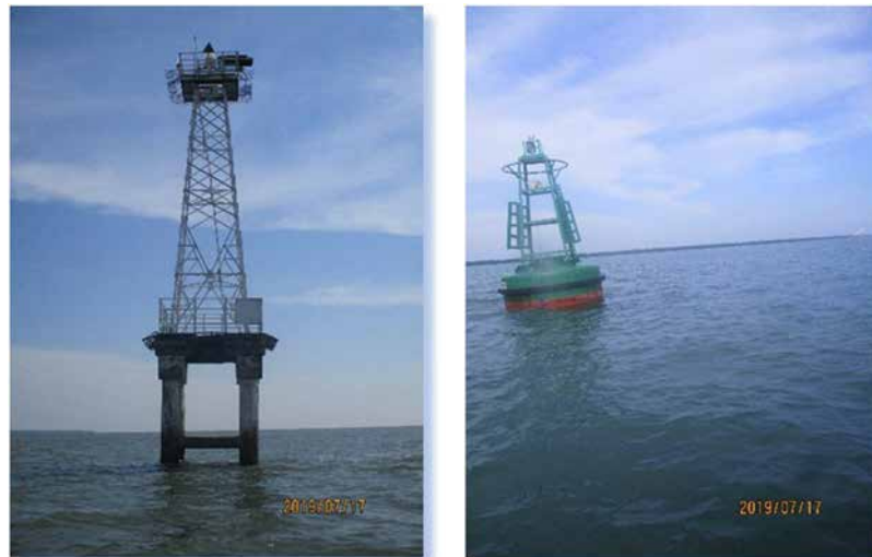
第 4.1.6 -4 写真 灯標 (左) 及び灯浮標 (右)
