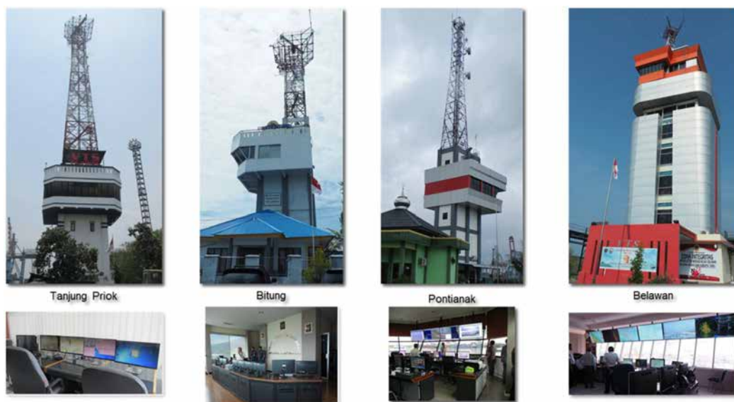
第 3. 1. 4 -1 写真 代表的な VTS の建物とその運用室
