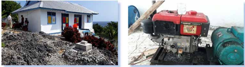
第 4. 1. 3 -7 写真 職員居住区及び発電機
