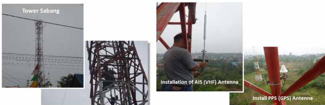
第5 -2 写真 AIS 空中線、GPS 空中線取付け
