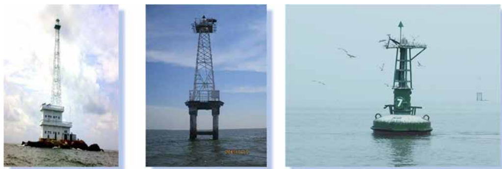
第 6.7 -1 写真 過酷な条件下に設置された標識（参考例）
