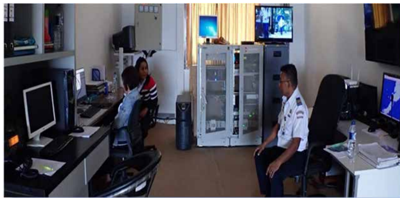
第 4.1.1 -3 写真 通信業務運用室
