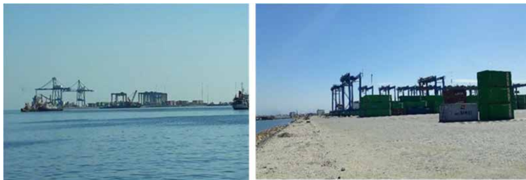
第 4.1.7 -4 写真 ガントリークレーン及びコンテナヤード
