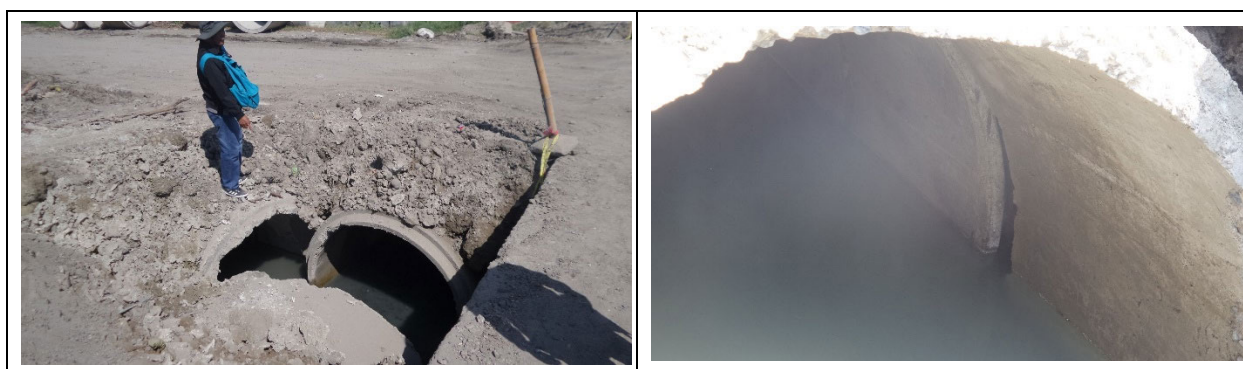
図 2.9.9 不適切な管路接合の事例
