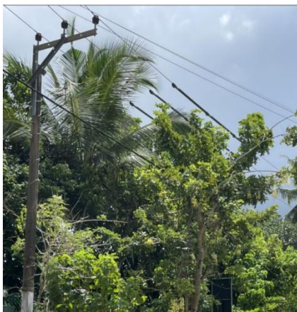
ARC 設置状況
