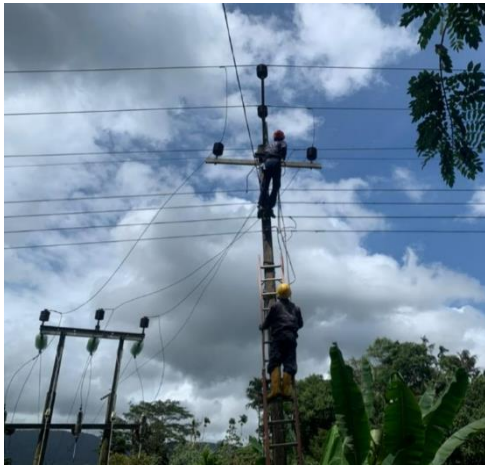
OCI 施工の様子
