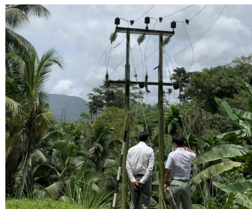
OCI 設置確認及びOJTの様子
