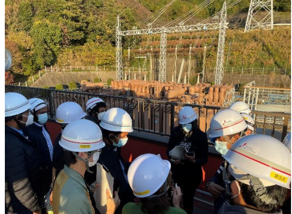
東清水変電所視察の様子
