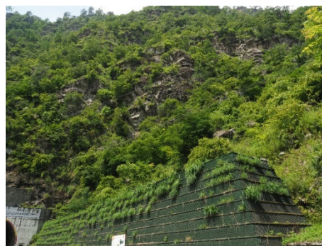
落石防護土堤背後の岩盤斜面
