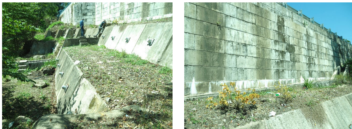
図 5-3 JICA 有償案件(LDPP)で整備されたアンカー工（左）と軽量盛土工（右）
