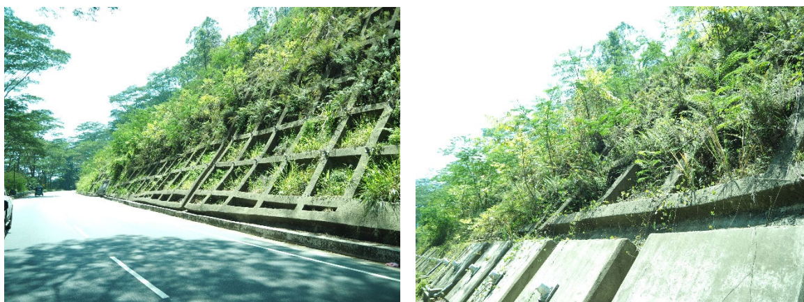
図 5-2 JICA 有償案件(LDPP)で整備された鉄筋挿入工とアンカー工を併用した法砕工
