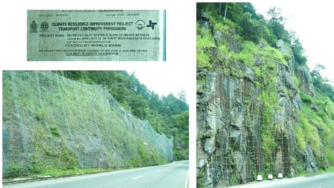
図 5-1 世界銀行の CRIP プロジェクトで施工された日本の落石対策工
