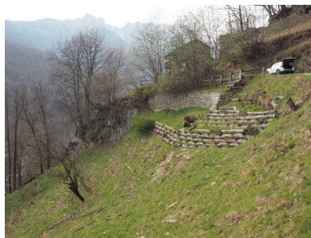
斜面崩壊対策
