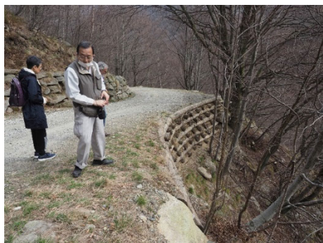
谷側の丸太井桁による盛土構築
