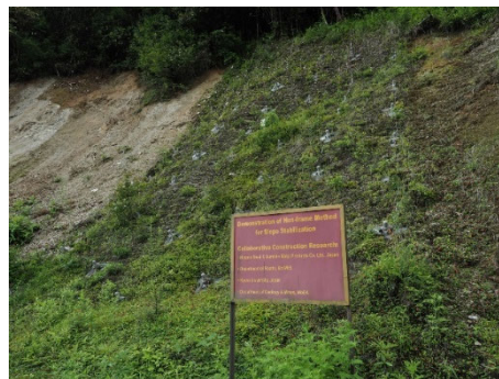
試験施工の看板
