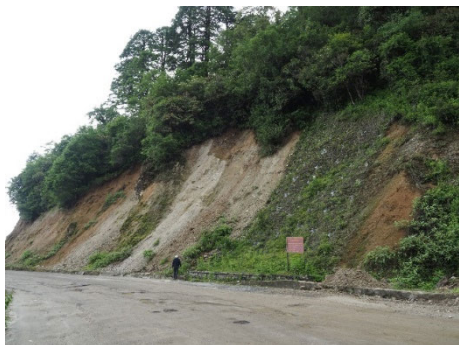
ノンフレーム工法の試験施工サイト
