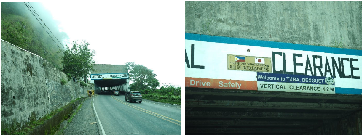
図 5-5 1993 年から 2001 年に実施された日本の Rosario-Pugo-Baguio 道路修復事業で施工されたロックシェッド
