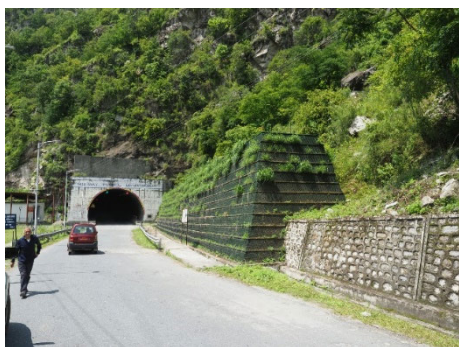
トンネル坑口手前の落石防護土堤
