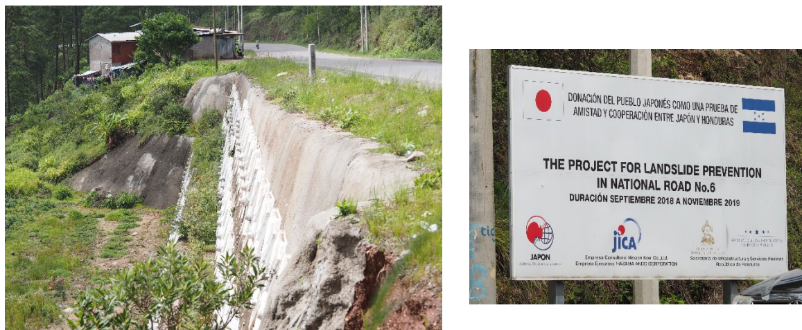
図 5-7 日本の ODA で実施した国道 6 号線の地すべり対策工(Sta.14.7km)。 排土工，吹付けコンクリート工，アンカー工
