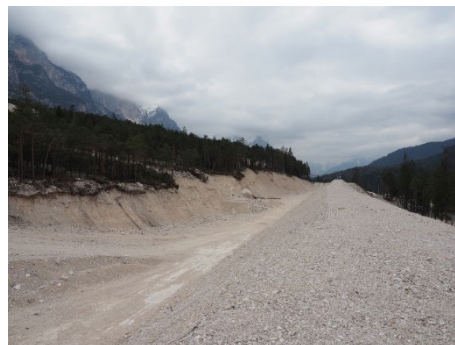
土堤背後の土砂溜め
