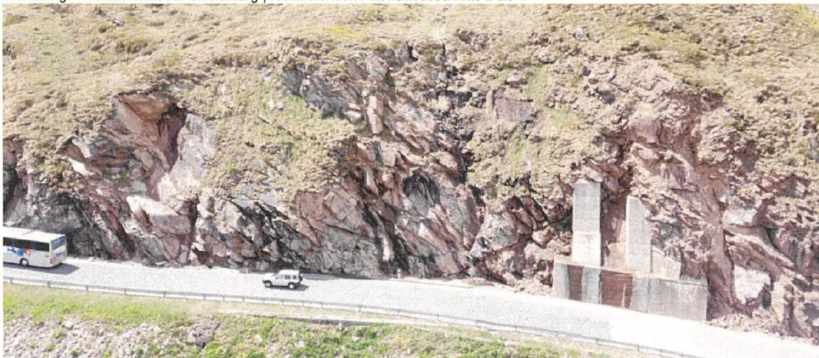
Abbildung: Fotoübersicht der Steinschlag-produzierenden Felswandabschnitte 2 bis 4
