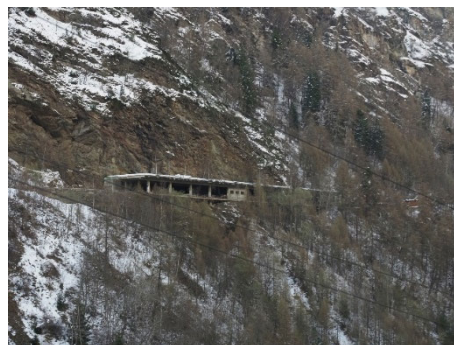
図 8-5 スイスの落石防護土堤（左）とシェッド工（右）
