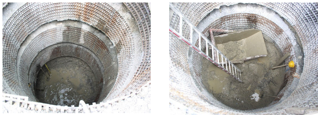
図 8-18 人力掘削の深礎杭の施工状況
