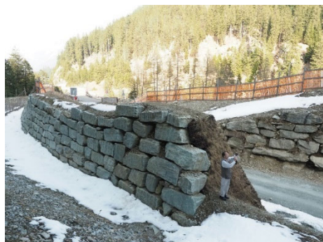
図 8-5 スイスの落石防護土堤（左）とシェッド工（右）
