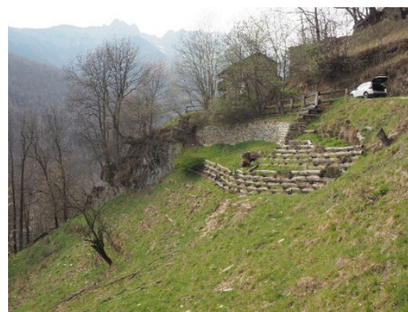
斜面崩壊対策
