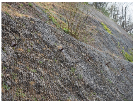
スチールネットとロックボルトによる対策 (イタリア)
