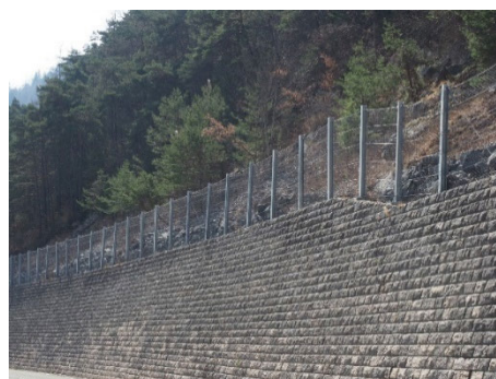
ブロック積擁壁と落石フェンス（フランス）
