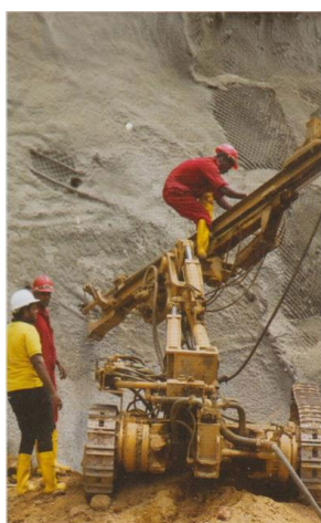
図 5-13 スリランカでの自走式のボーリングマシンによる削孔作業（左）と単管足場を使ったソイルネーリングの削孔・挿入作業（右）
