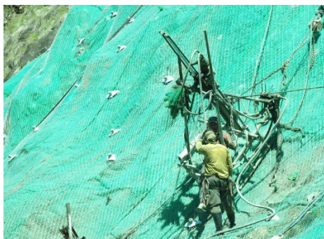
図 5-11 フィリピンでのソイルネーリングの削孔挿入（左）と金網の配置前の転石等の除去（右）
