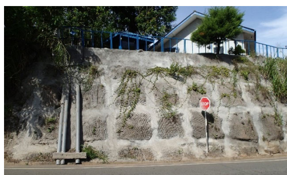
2000 年代から実施されているスリランカ方式の埋め込み型法枠工の例
