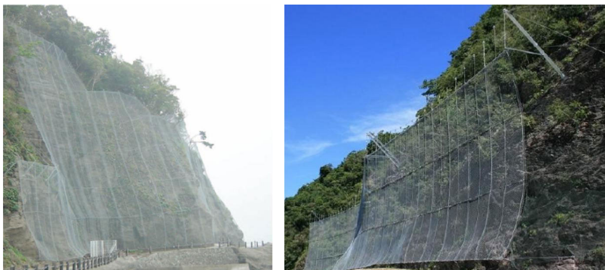
(a) 従来型のポケット式落石防護網の例
