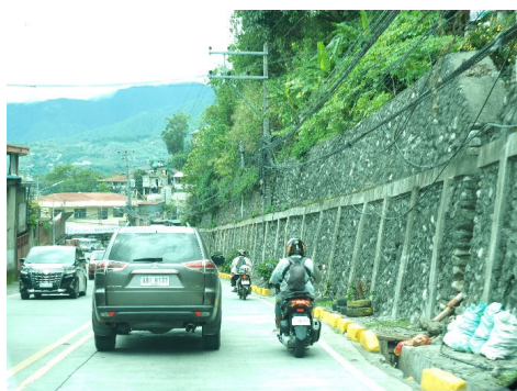
図 5-2 国道や市街地の道路でよく見掛る場所打ち法枠工併用の練り石積擁壁
