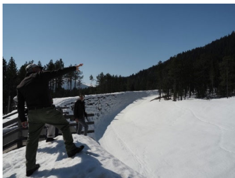
土石流と雪崩対策の堰堤背後の土砂溜め
