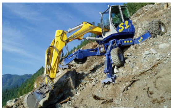
急傾斜上での作業
