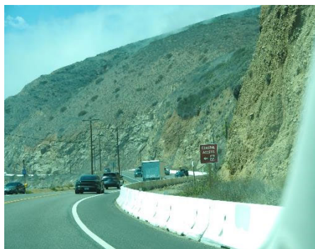
コンクリートブロックによる落石ポケットの確保
