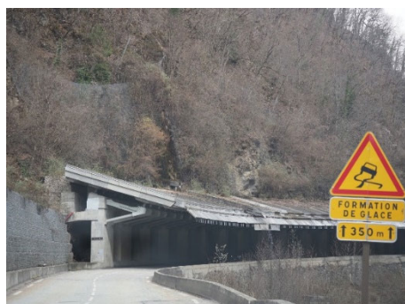
落石防護シェッド（フランス）
