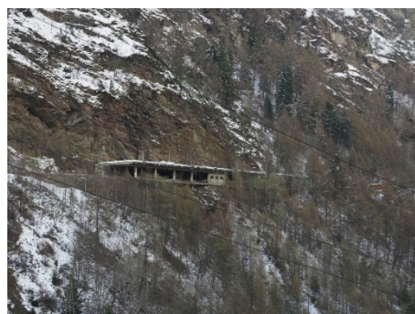
落石防護シェッド（スイス）
