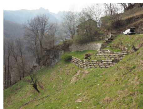
バイオエンジニアリングによる対策 (イタリア)
