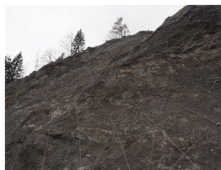
ネットとケーブル、ネイリングによる対策 (イタリア)
