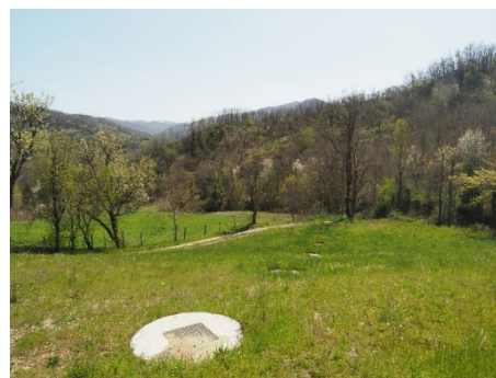
小口径集水井天端のコンクリート構造物
