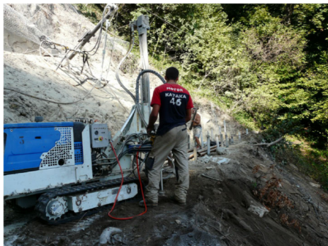
マイクロパイルの施工機械
