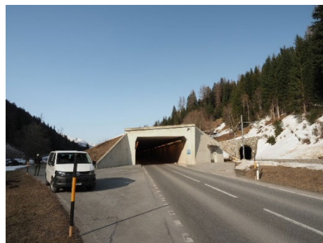
雪崩土石流対策シェッド
