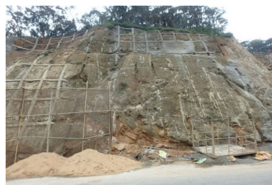
スリランカ方式の埋め込み型法枠工とソイルネイリングを組み合わせた例
