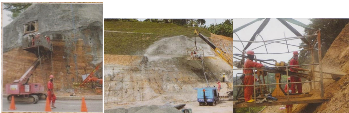
図 5-14 スリランカでの重機を利用した2種類の足場（左：クレーンのアームの先端に作業台を直接設置、中央：クレーンで吊り下げた作業台、右：中央の写真の作業台部分）
