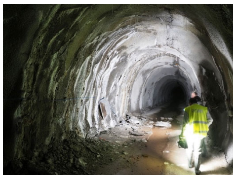
排水トンネル（San Lorenzo トンネル）
