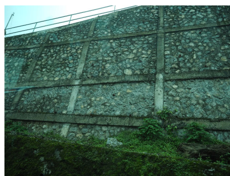
図 5-2 国道や市街地の道路でよく見掛る場所打ち法枠工併用の練り石積擁壁
