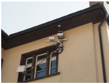
落石を検知するドップラーレーダー
