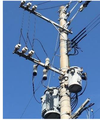
Exemple d'utilisation du coupe-circuit étanche et de l'isolateur support à tige
