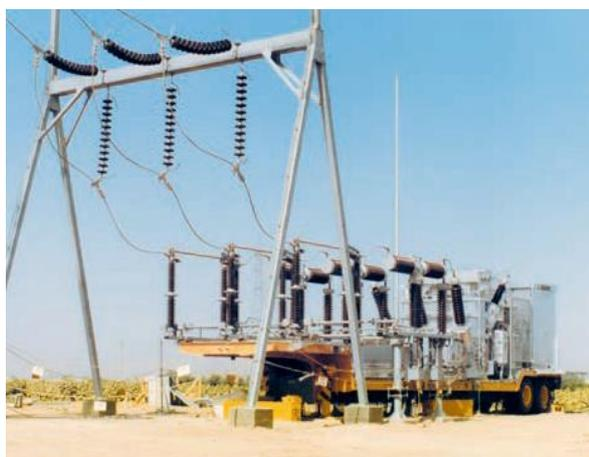
Type intégré (raccordement à la ligne aérienne à haute tension)
