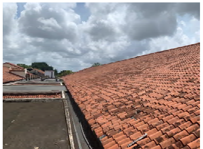
Bブロック屋根 (パネル設置)
