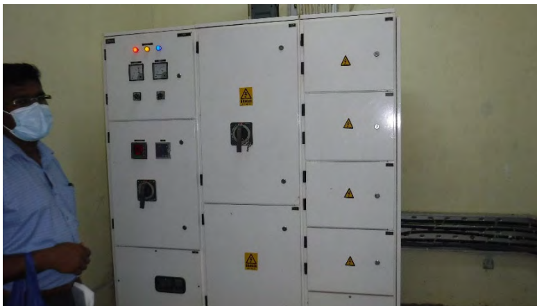
新設Kidneyビル用 受電開閉設備
