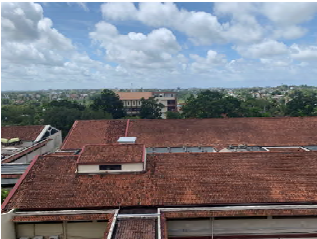
Bブロック屋根 (パネル設置)
