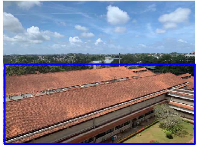
Bブロック屋根 (パネル設置)
