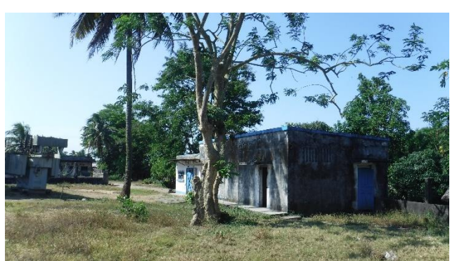
TM2-⑥ 新設変電所建設候補地
