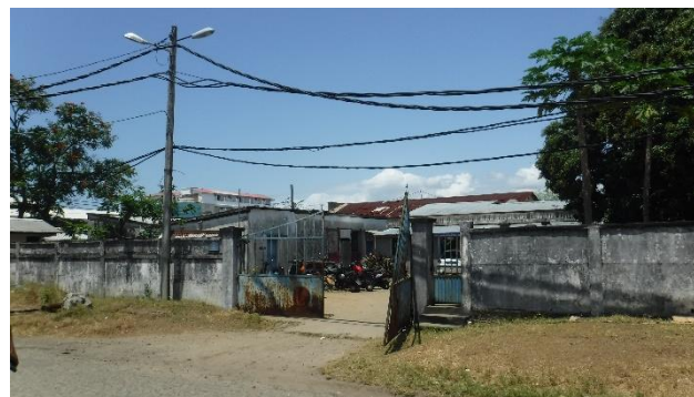
TM1-⑥ 新設変電所候補地-3
