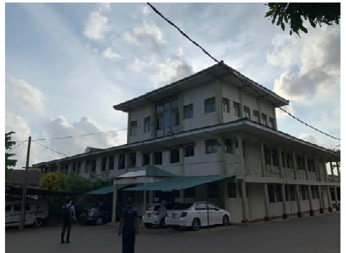
ward31&32 (パネル設置)
