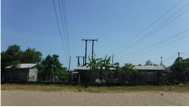
DL-① TM-220 向け準送電線ルート調査 既設 Volobe-1 水力行きラインと同方向となるため、現在不使用中の Old ライン ROW の確認を行った。TM-2 出口付近より非正規に建てられた住宅が広がる。
