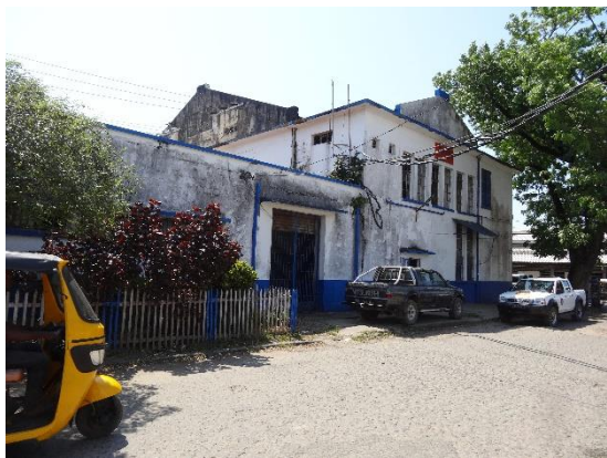
TM1-① 変電設備建屋全景
