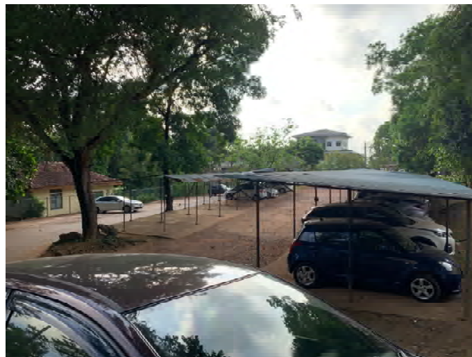
駐車場 (パネル設置)
