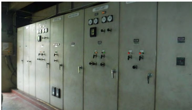
415V 低圧主幹盤及び分電盤
