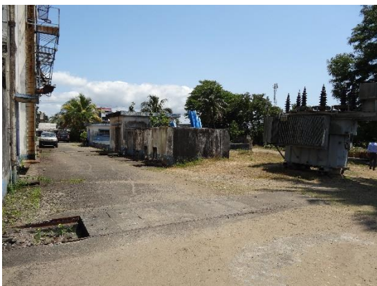
TM2-⑤ 新設変電所建設候補地
