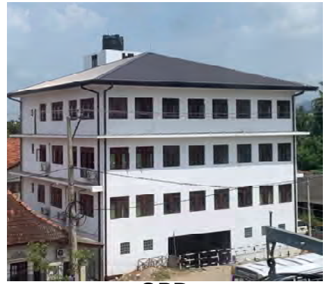
OPD (パネル設置)
