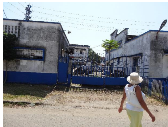
TM1-④ 新設変電所候補地-1
