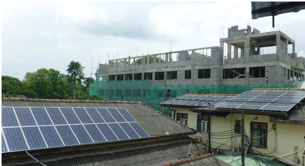
既設太陽光パネル
