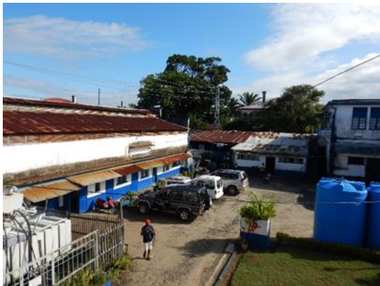
TM-1 変電所 (トアマシナ地域事務所隣接)
