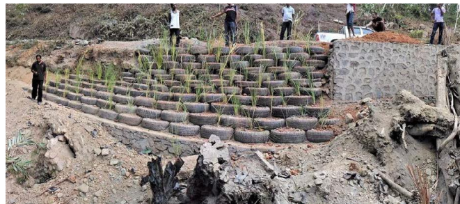
古タイヤ斜面对策試験施工 ※事業完了報告書から
