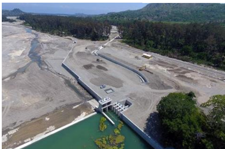
写真:取水施設俯瞰
