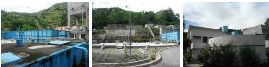
修復・更新された3つの浄水場（左からベナマウク、ベモス、ラハネ）
