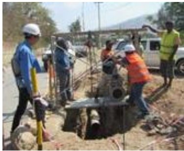
流量調整のための バルブ設置工事指導 ※JICA の HP から
