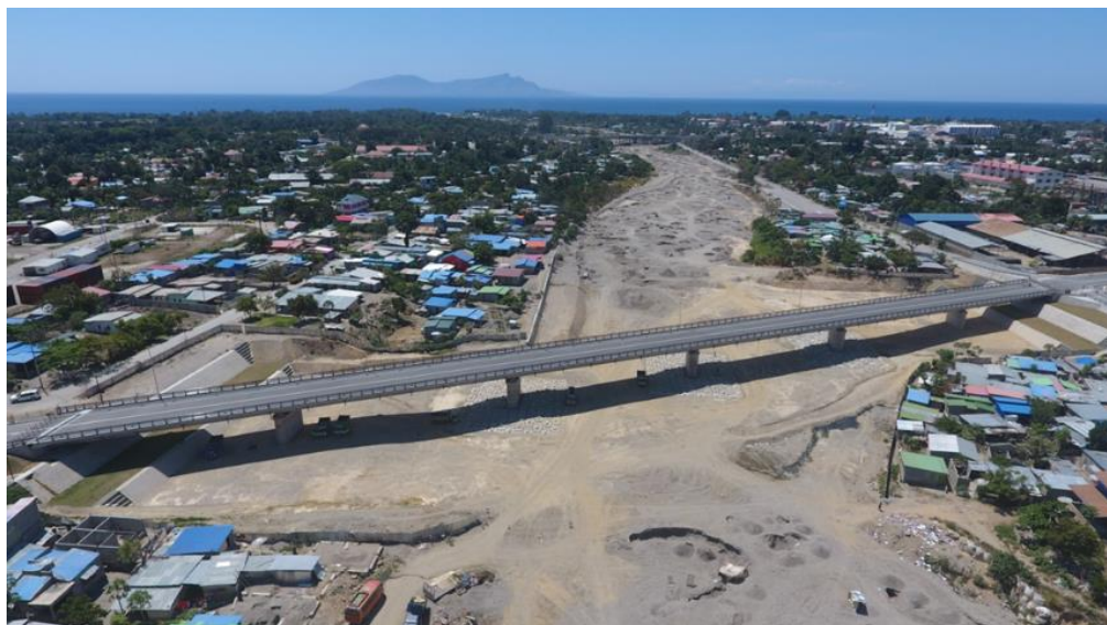
写真：完成した日の出橋
