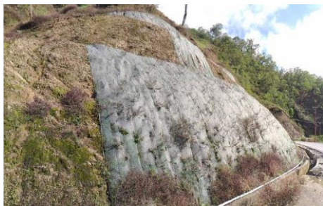
Pilot Construction: Multi-functional Net ※事業完了報告書から
