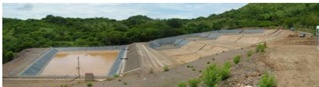
写真 7-26 新たに建設された衛生埋立処分場（フェーズ2）
