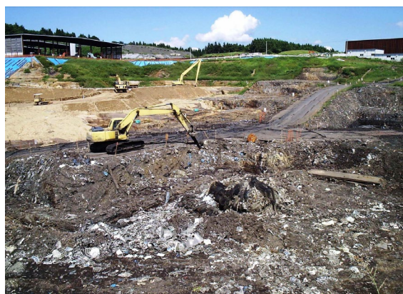
写真 5-8 廃棄物の掘削（2012年）
