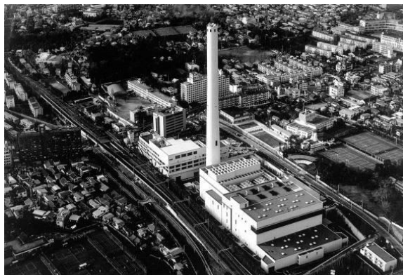
写真 6-8 杉並清掃工場
