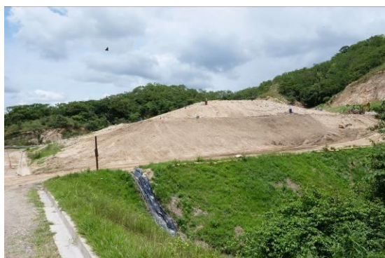
写真 7-38 衛生埋立処分場全景
