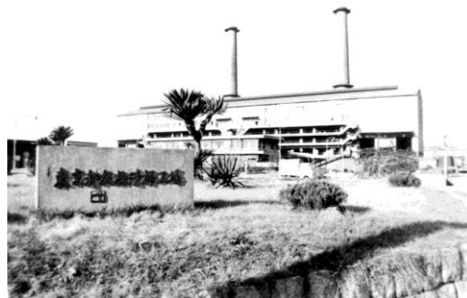
写真 6-4 板橋清掃工場（1961年竣工）
