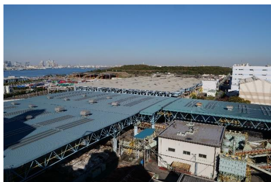
写真 6-12 不燃ごみ処理センター及び粗大ごみ処理施設外観
