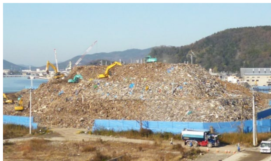
写真 5-11 一次仮置場の状況 (石巻市：2012年11月)
