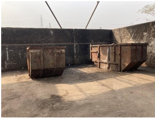
写真 7-49 中継所に設置されたコンテナ
