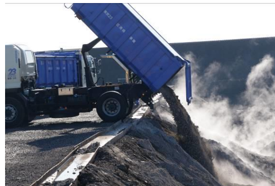
写真 6-15 最終処分場での埋立の様子 (⑤中央防波堤外側埋立処分場)
