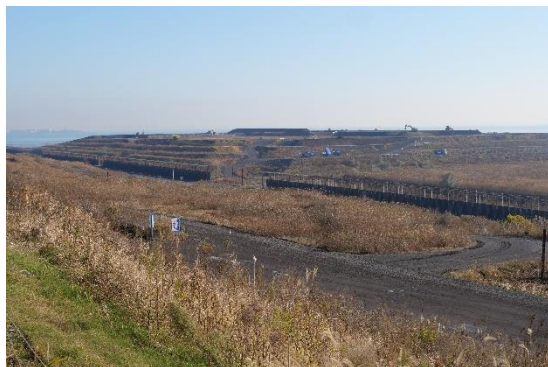
写真 6-14 最終処分場外観 (⑤中央防波堤外側埋立処分場)
