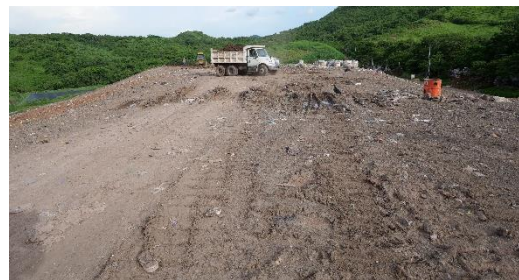
写真 7-28 フェーズ3 埋立地（上部）
