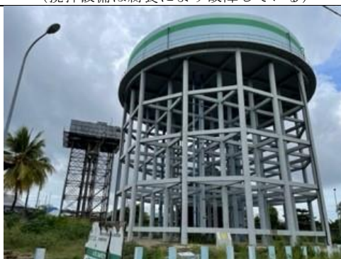
巻頭写真4 サティニー配水池 (AfDB 事業により建設。下流側の給水時間は一日数時間。 円借款事業で上流側のウエレゾ配水池からの送水管を建設 予定)
