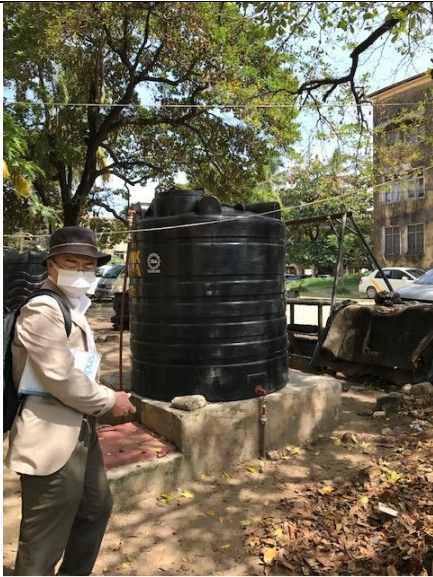
巻頭写真 9 水利用者へのインタビュー調査 訪問家庭 (断水のため多くの家で戸外にタンクを設置)
