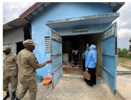
写真 2-6 無償資金協力で整備した消毒設備
