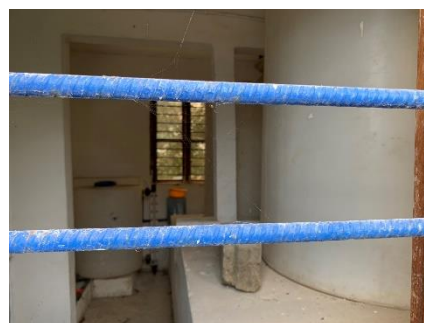
写真 2-8 ZUWSP で整備した消毒設備(2)
