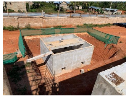
写真 2-2 配水池流入流量計室
