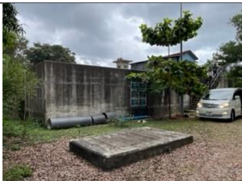
巻頭写真1 ウエレゾ配水池 (2008年無償資金協力にて建設)
