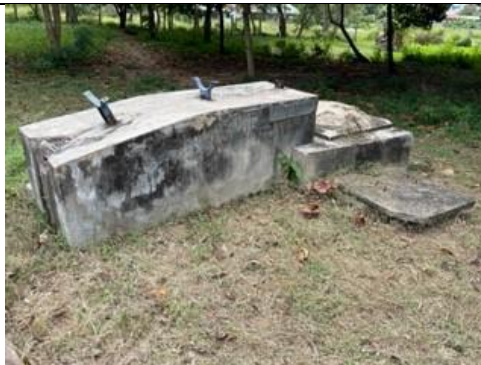
巻頭写真8 塩水化で使われなくなった生産井
