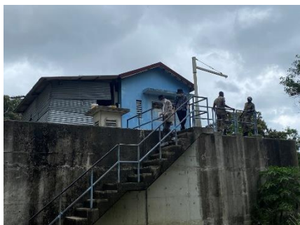
写真 2-5 ウェレゾ配水池
