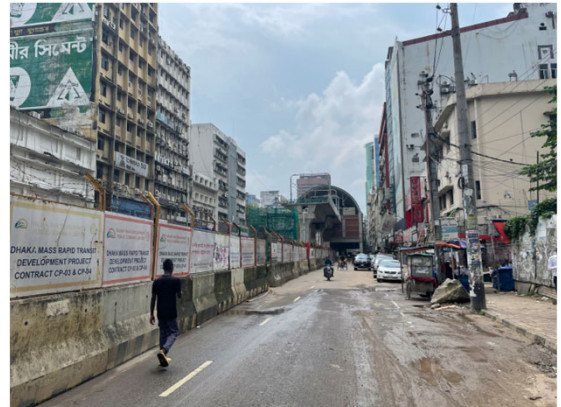
মতিঝিল স্টেশনে নির্মাণ স্থান (কমলাপুর অংশ) সূত্র: জাইকা বিশেষজ্ঞ দল
