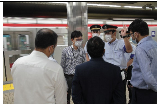
写真 26: 可動ホーム柵の説明(2)
