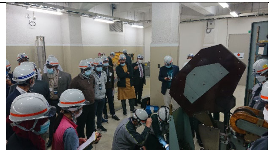
写真 40：遮断器の保守作業の視察
