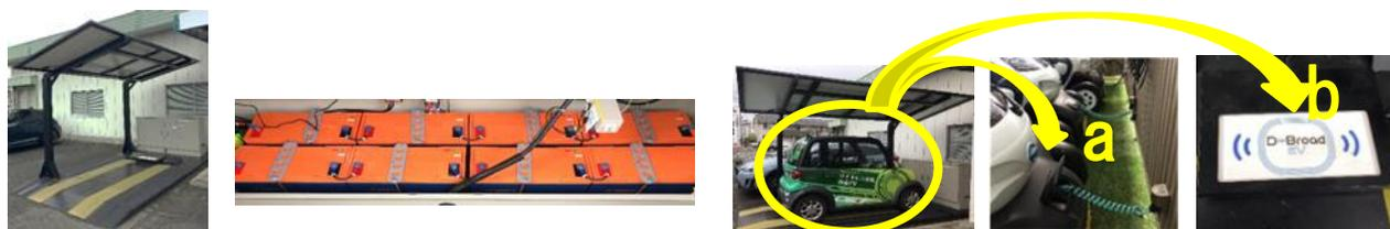
①太陽光で発電 ②作った電気をバッテリーに蓄電 ③車両を充電（a AC コンセント／b 非接触充電装置）
