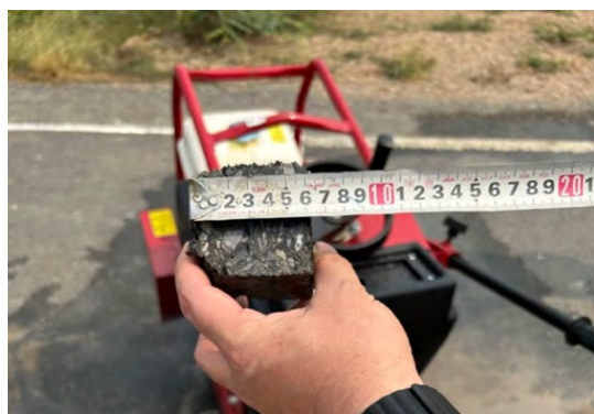
テスト施工箇所路面調査 (2023.3.14)
