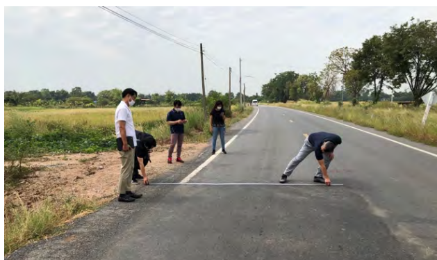
テスト施工予定地視察 (2022.11.6)
