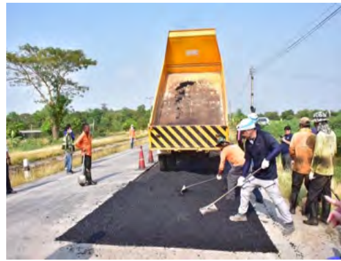
テスト施工 (2023.3.14) 再生アスファルトでの舗装
