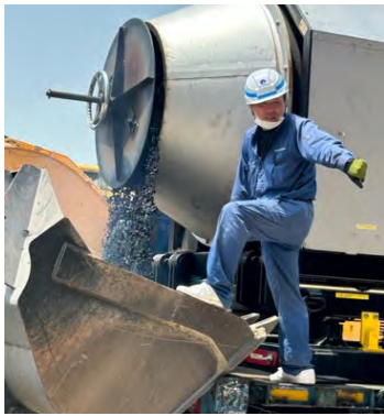
テスト施工 (2023.3.14) 再生アスファルト製造～排出
