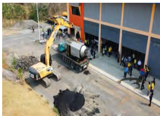
テスト施工 (2023.3.14) 既設アスファルト ASRR-B2 へ投入
