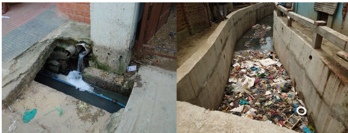
図 5.1.6 側溝への家庭排水と水路閉塞の状況
