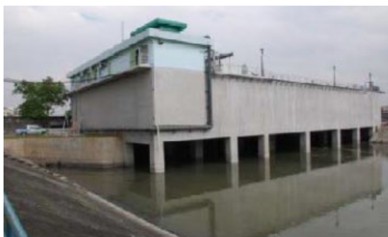
図 5.2.19 遊水池の上部空間を利用して作られた処理場
