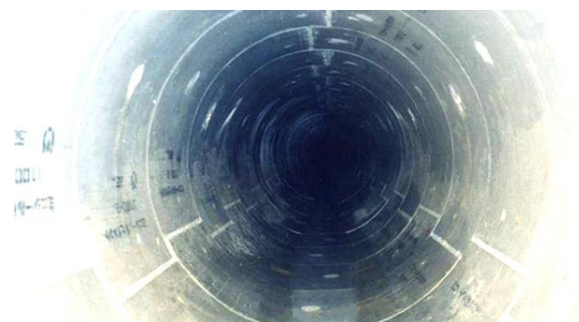
セグメントが組み立てられた内管（施行後）
