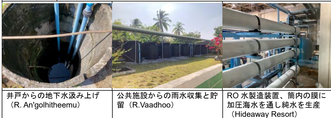
井戸からの地下水汲み上げ (R. An'golhitheemu) 公共施設からの雨水収集と貯留 (R. Vaadhoo) RO 水製造装置、筒内の膜に加圧海水を通し純水を生産 (Hideaway Resort)
