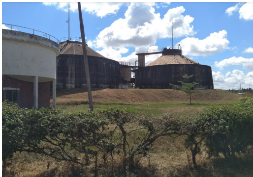
汚泥処理施設
