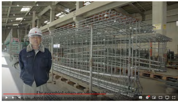
橋梁上部工製作オンデマンドビデオ
