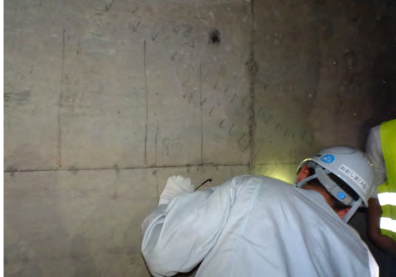
Settat 州箱桁橋の視察（上：外部、下：内部）
