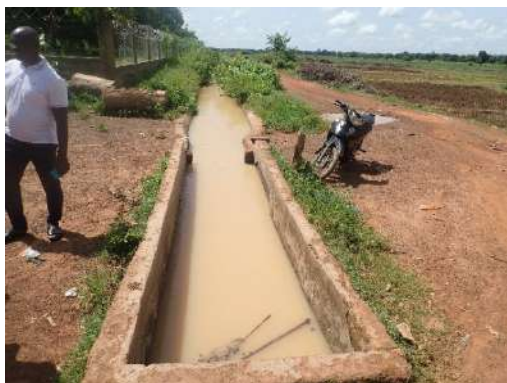
Boulbi 灌漑区:左岸幹線水路の状況
