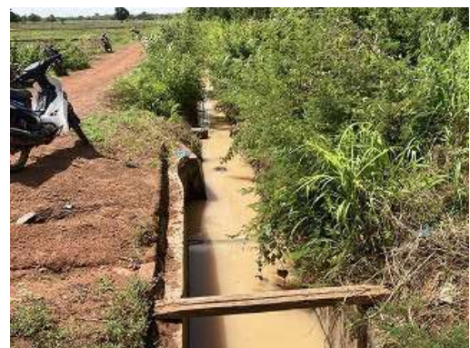
Boulbi 灌漑区:右岸幹線水路の状況
