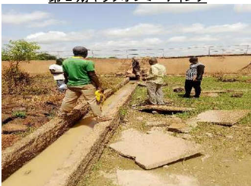
機能診断調査(施設調査)
