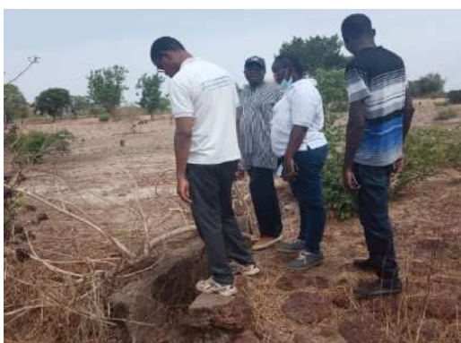
対象2州の灌漑施設現況調査(調査風景)
