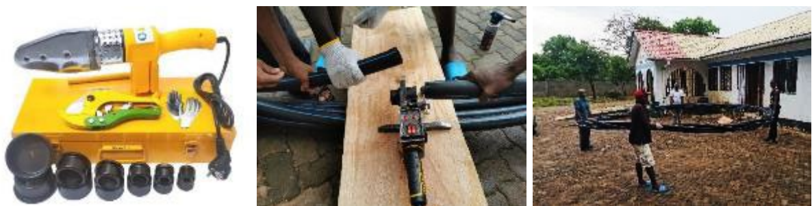
図 56. 50mm HDPE パイプを使った小型生簀（5m 直径）の生簀
