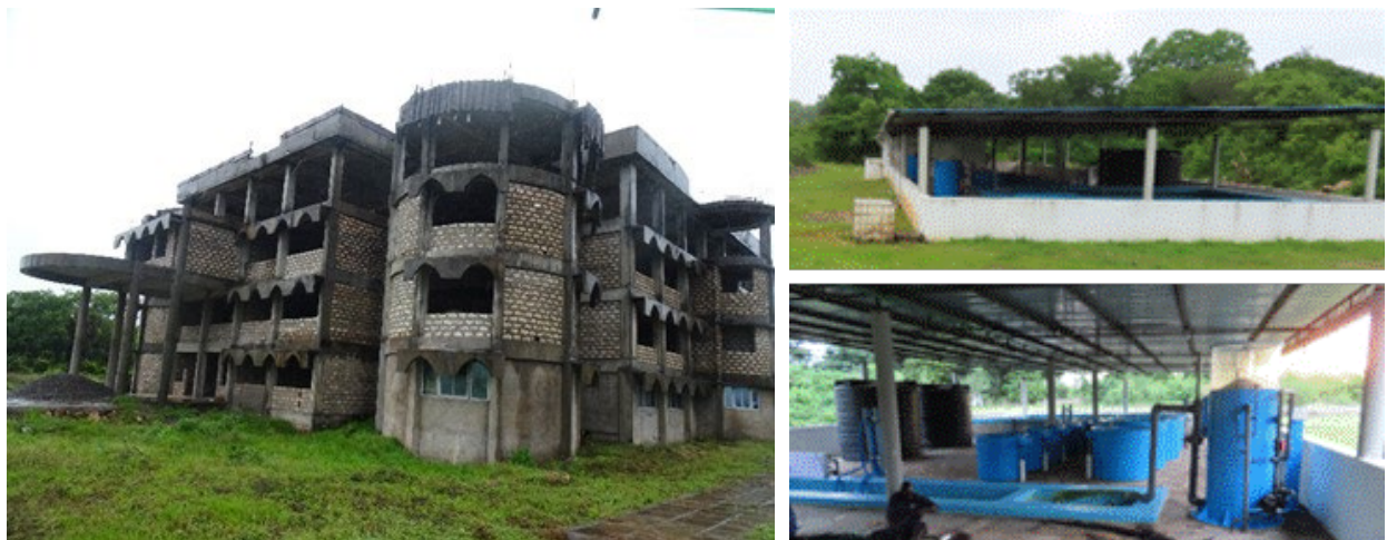
図 3. クワレ郡シモニに建設中の National Mariculture Resources and Training Centre (NAMARET)（左）、一部使用中の孵化施設（右）
