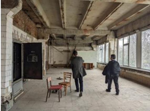
Moldova-2 専用スタジオに改修予定のテクニカルセンター現状（建物の南西側）。スタジオの改修に合わせて機材の整備も必要である。
