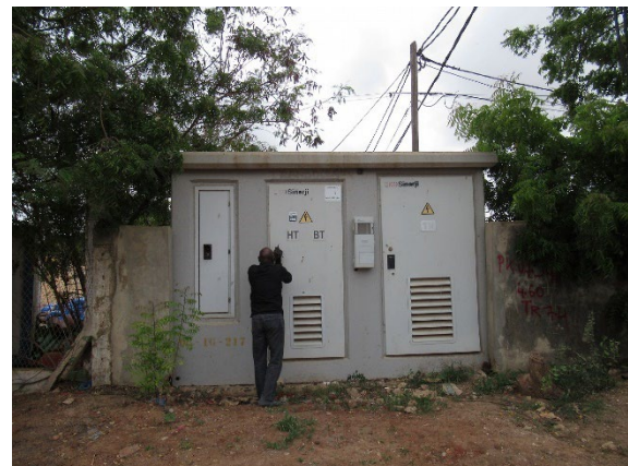
Figure 2-2-17 Exemple de local préfabriqué pour transformateur
