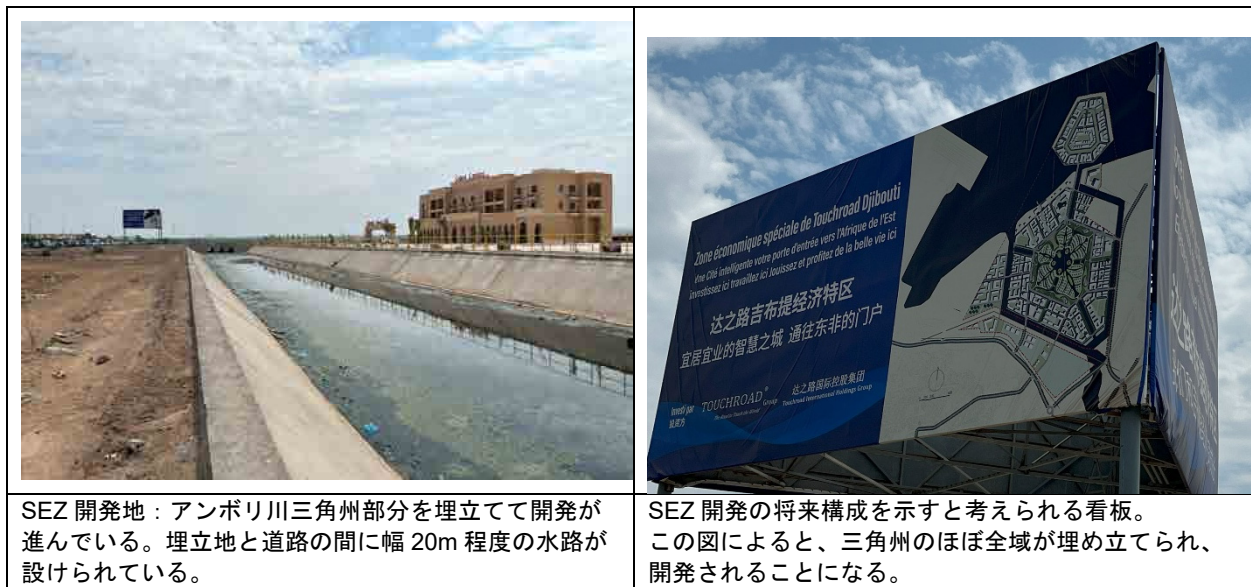
図 2.3.5 アンボリ川三角州部分における SEZ 開発の様子
