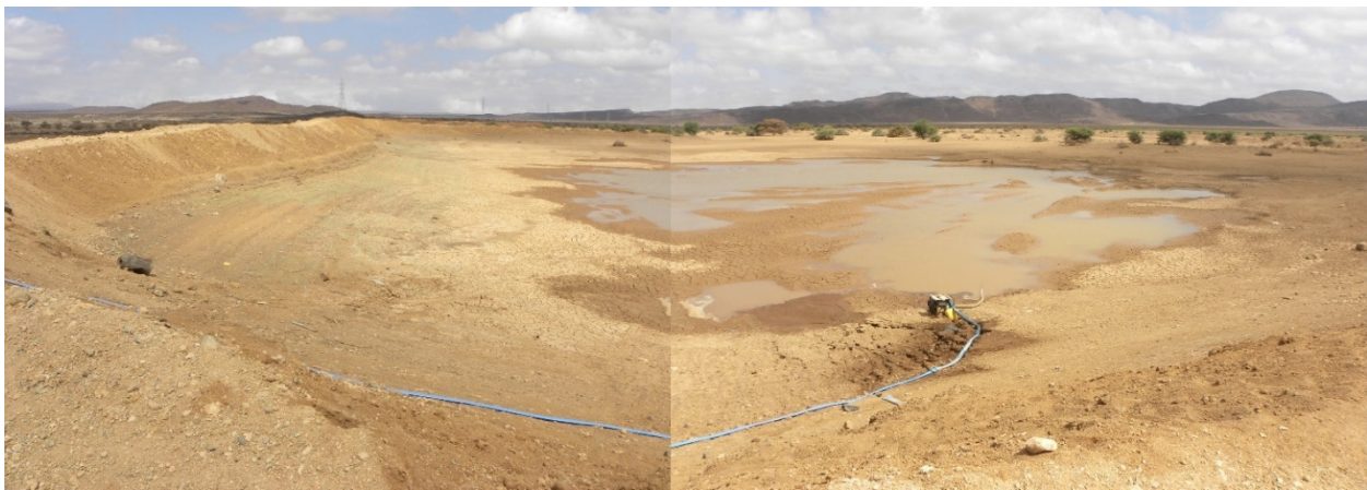
盛土によるため池（グランバラ）
