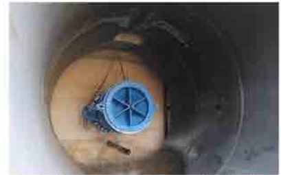
貯水位を下げるための底部排水管 (最大：12 m 3 /s)
