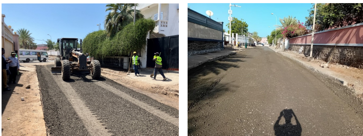
Situation de la mise en place de la couche d'assise avec traitement.
