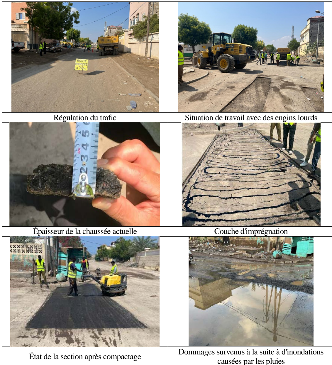
Figure 3.3-2 Photographies de l'état des travaux de réparation conventionnelle
