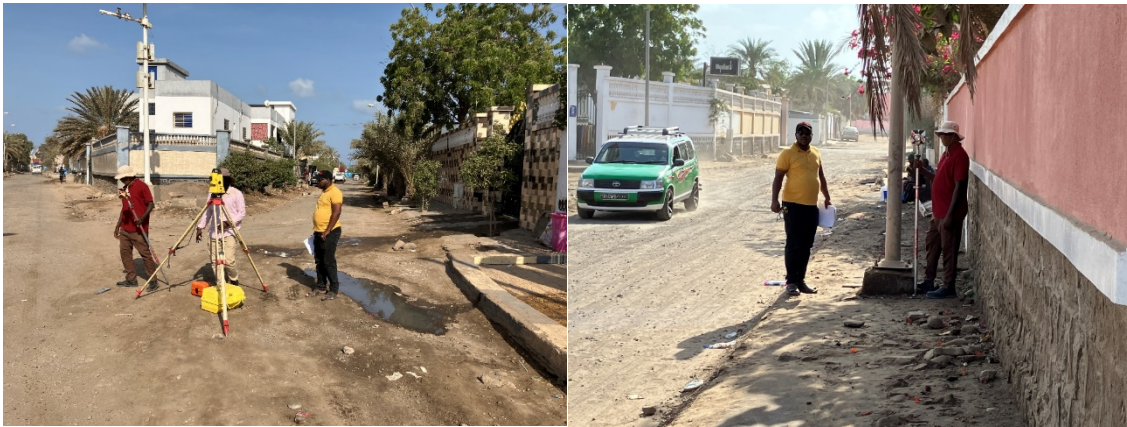
Figure 3.3-16 Levé topographique de la réparation pilote 3
