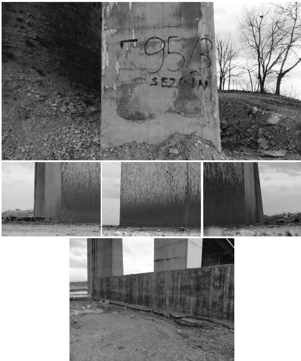
図5－111 観察された地盤面の低下の例
