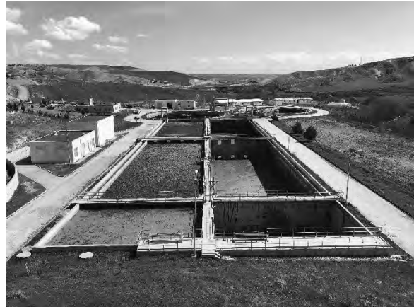
右の沈殿池は被害状況確認のため放流
