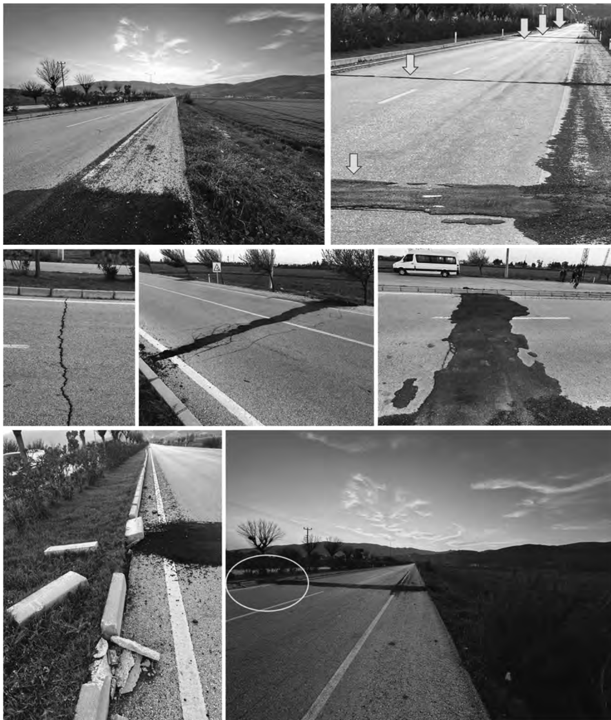
図5-20 観察された損傷の例
