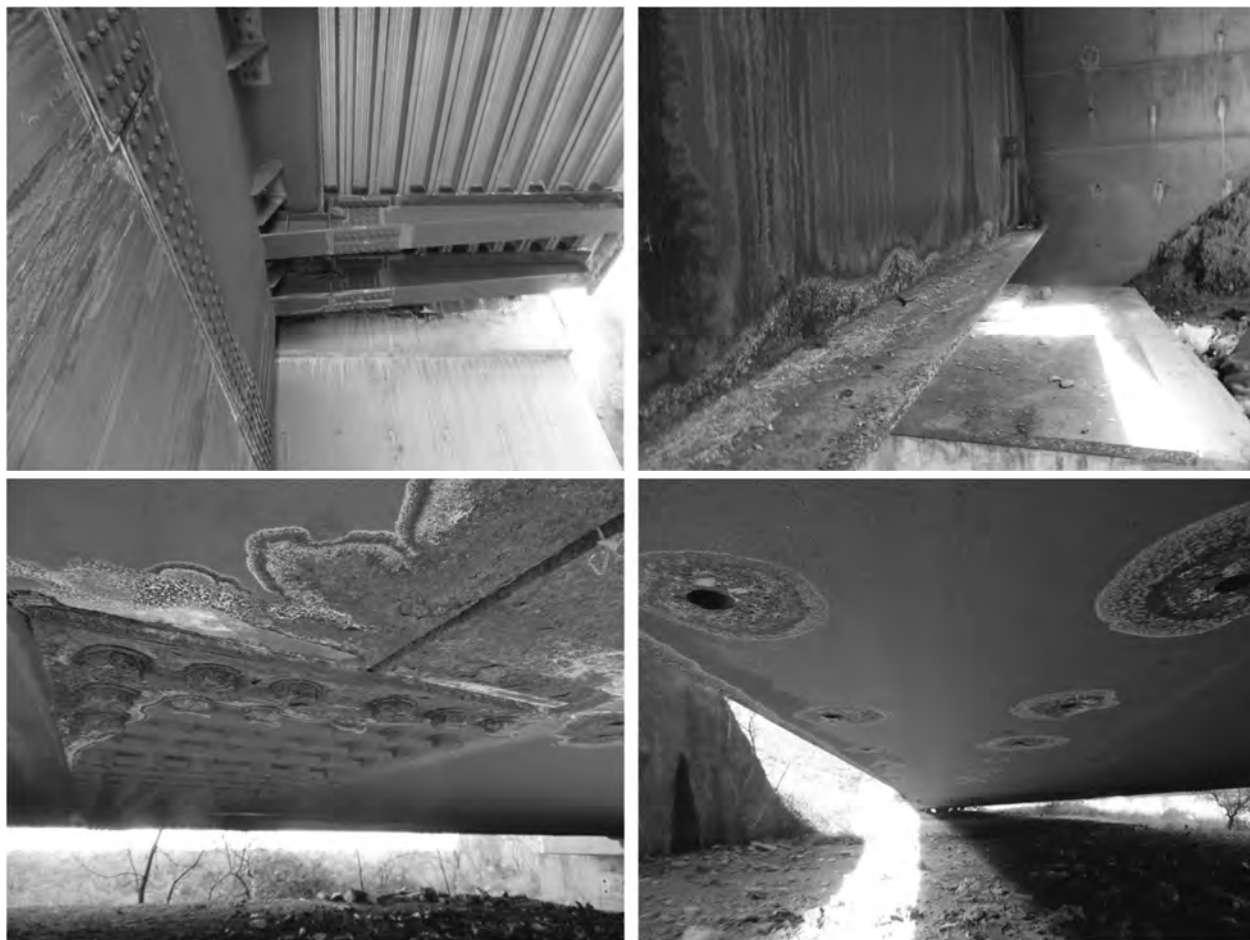
図 5－63 観察された損傷の例
