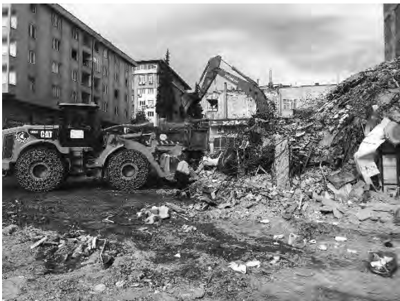
カフラマンマラシュ県瓦礫処理状況
