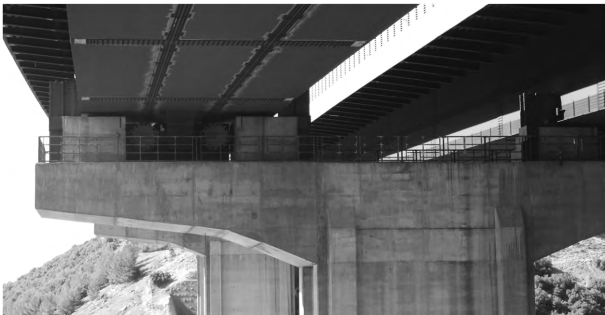
図 5－42 橋脚上の上下部接続部の構造
