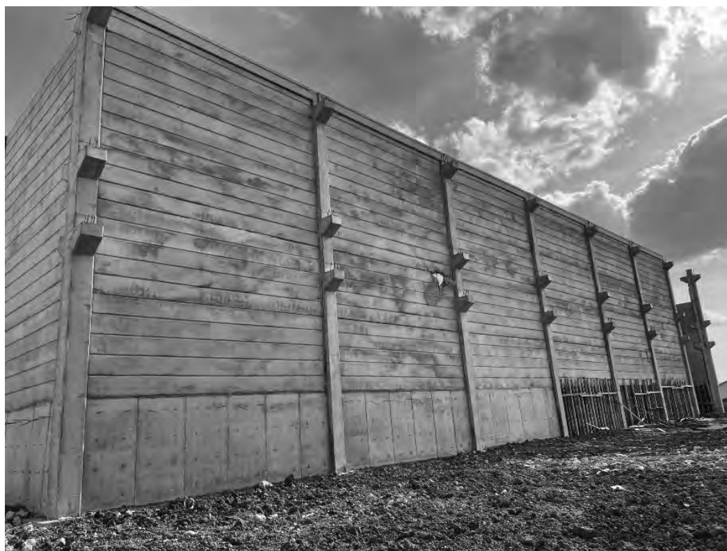
図3-27 プレキャストコンクリート造の工場
