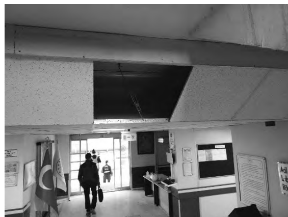
(b) 天井材の脱落
