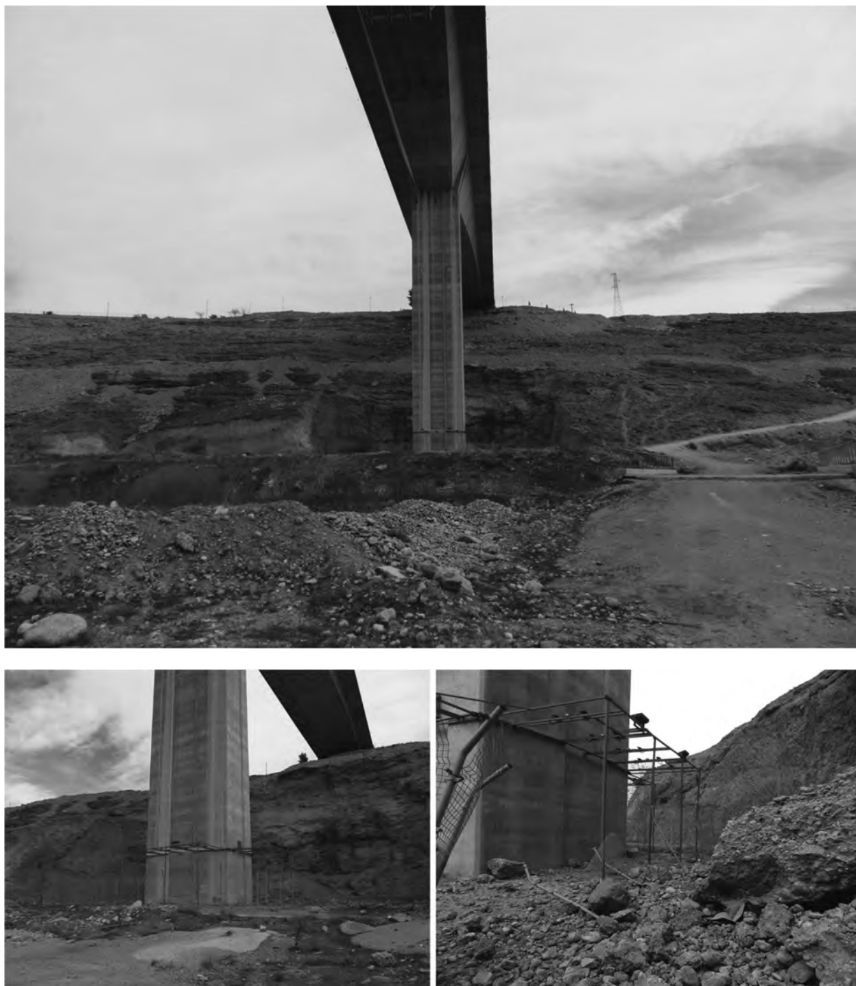
図5-91 橋脚周りへの落石
