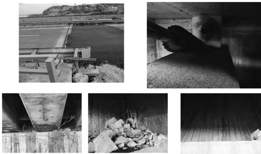
図3-55 マラティア市街側の橋台周りで見られた損傷（トーマ橋）
