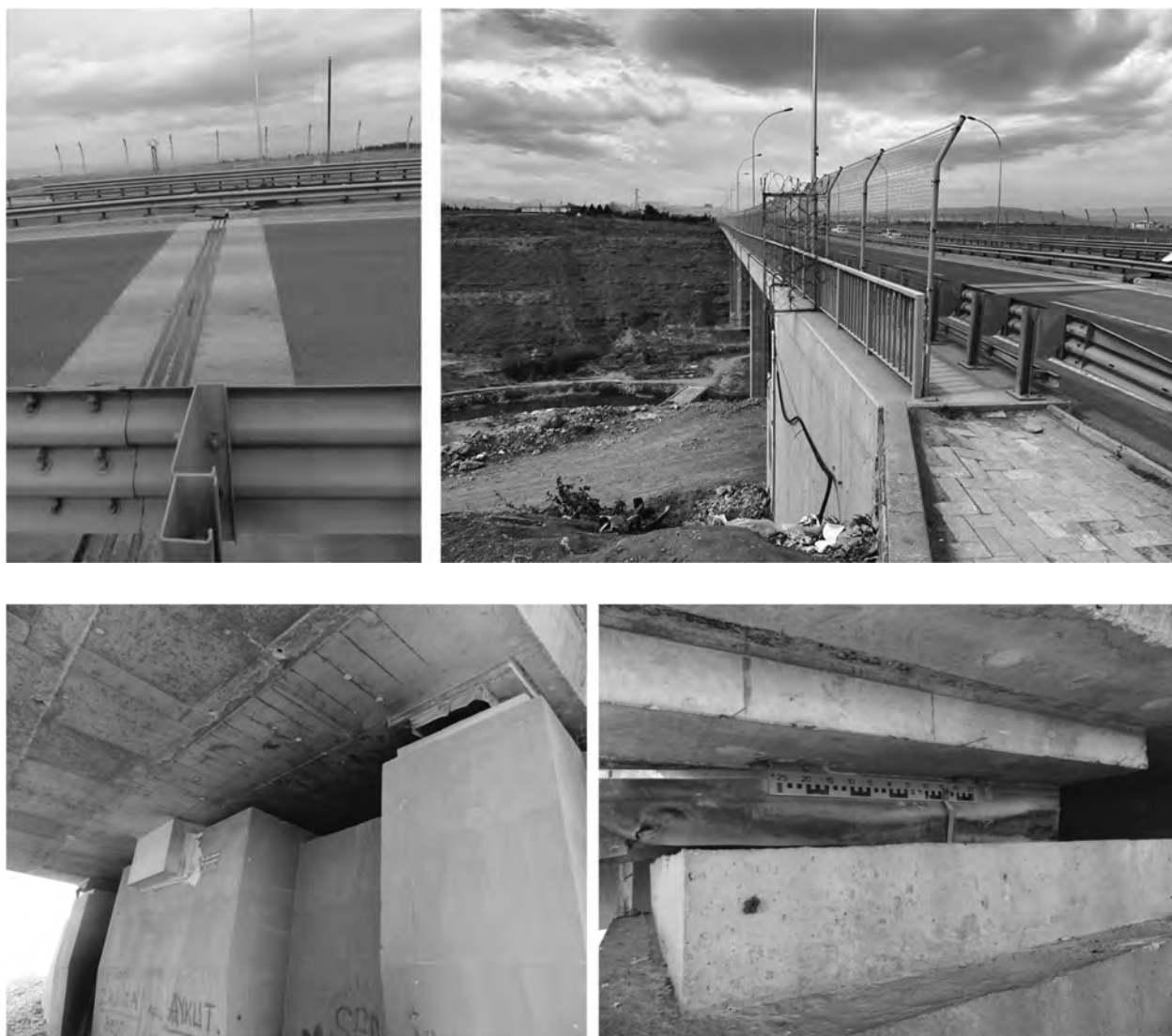
図5－87 観察された損傷の例
