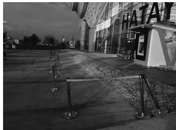
(d) 建物周辺の地盤沈下（アンタキヤ）
