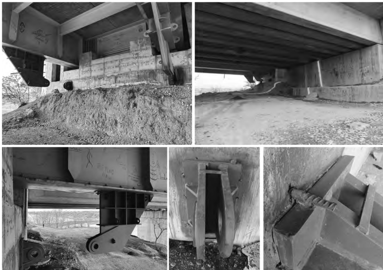
図 5－107 北側橋台前面に設置された治具
