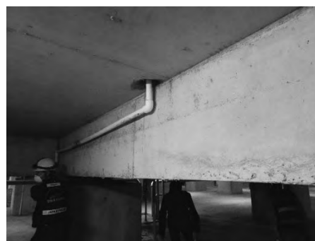
(b) 縦配管設置状況
