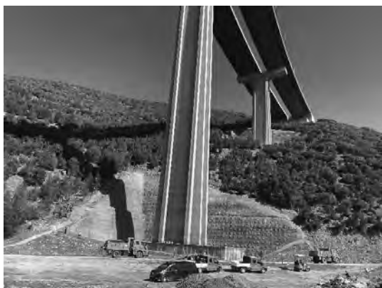
(a) 橋脚の設置状況（ヌルダー）
