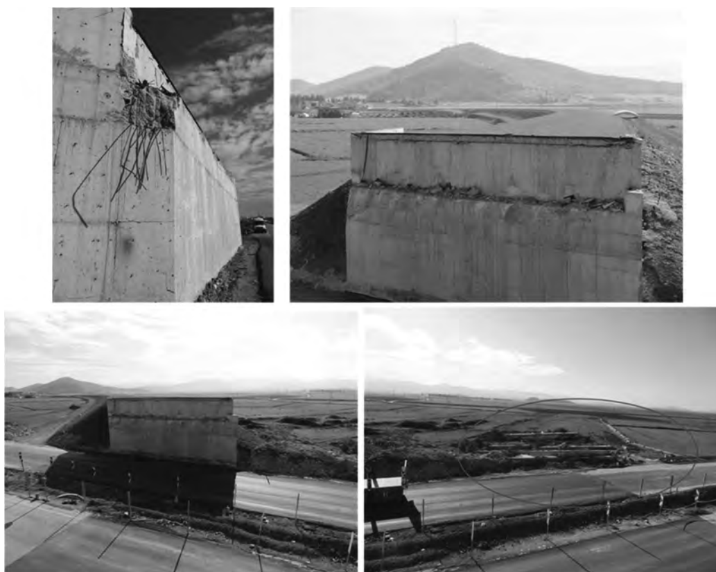
図3-53 開通前の国道の道路橋の落橋（ヌルダー市郊外）
