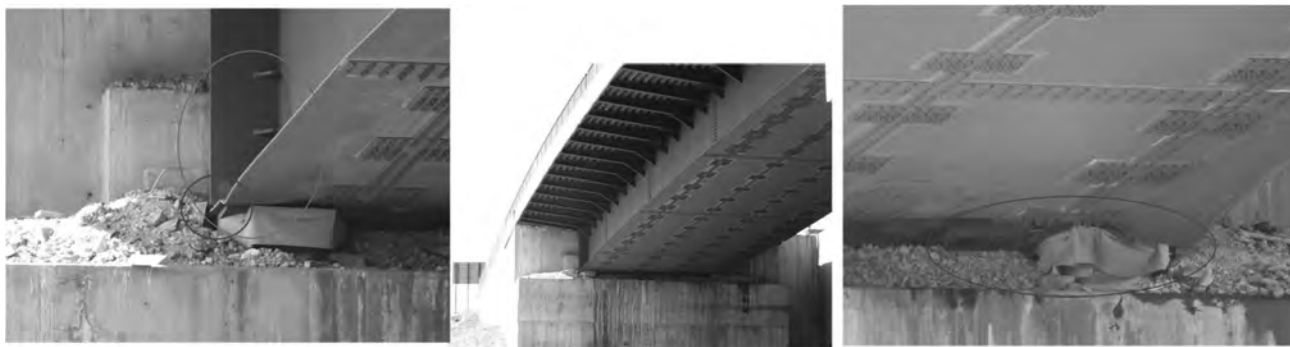
図 3－46 鋼桁端部の損傷（ヌルダー高架橋）
