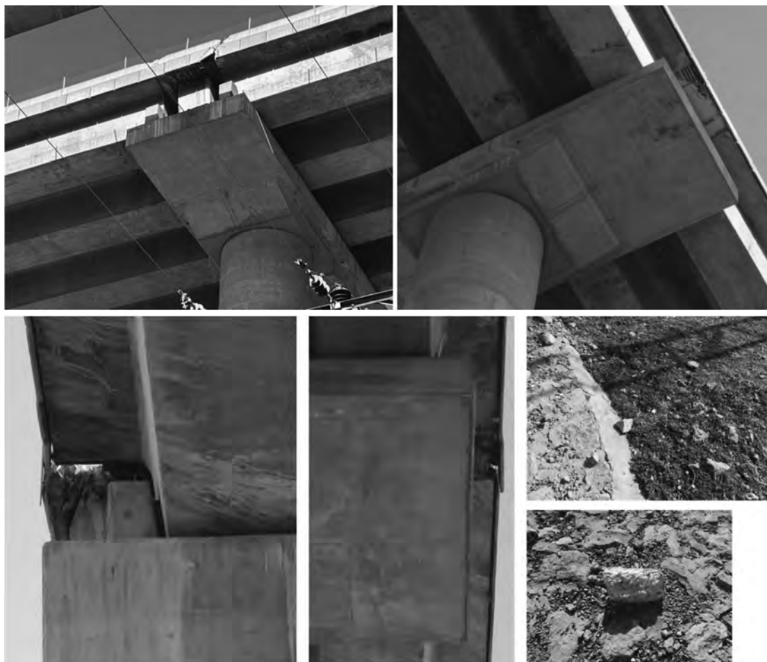
図5-33 観察された損傷の例
