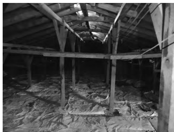
(b) 天井材の脱落
