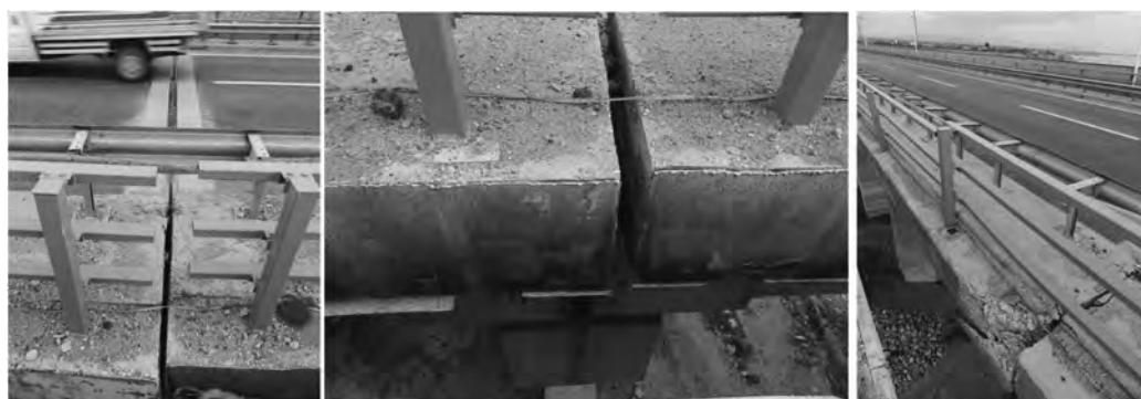
図3-56 桁どうしのずれ（トーマ橋）
