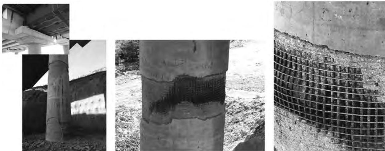
図 3－45 かけ違い部橋脚の損傷（ヌルダー高架橋）
