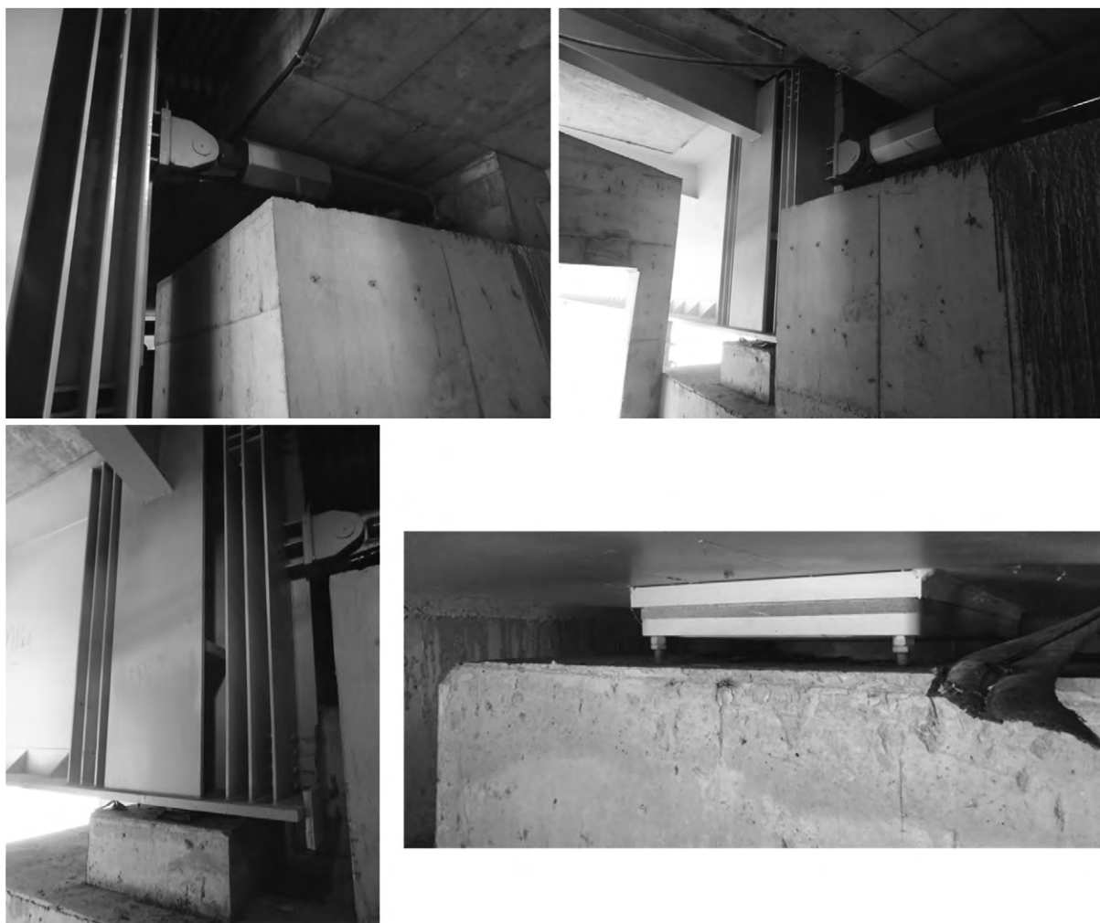
図5-108 北側橋台部のダンパーと支承
