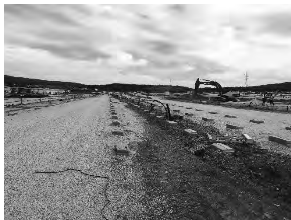
コンテナハウス用基礎、上下水道管
