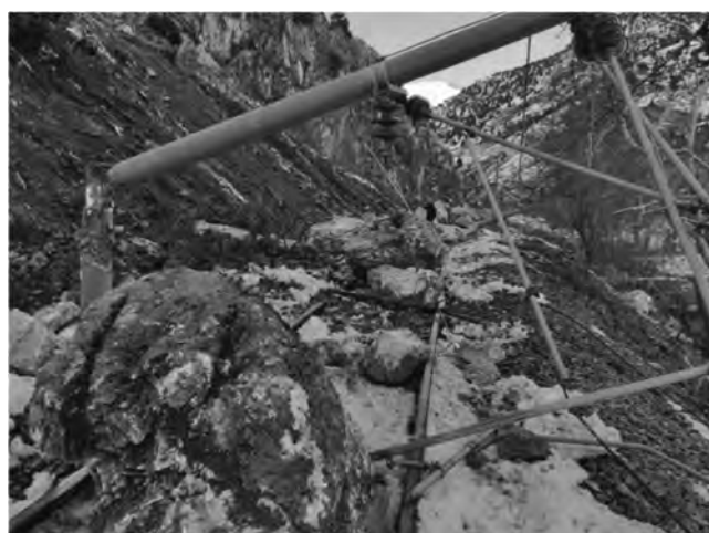
図 3－61 落石による被災例
