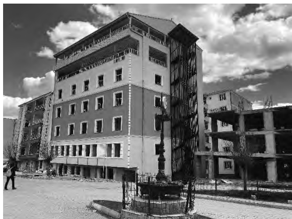
(c) 地盤沈下による建物の沈下（アドウヤマン）
