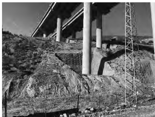
(b) 橋脚の設置状況（ヌルダー）
