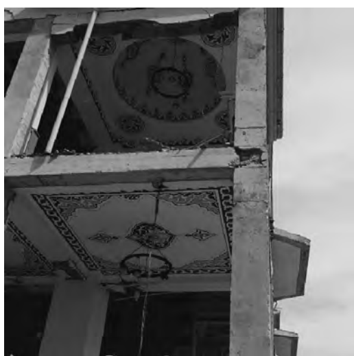
(a) 2 階柱梁接合部
