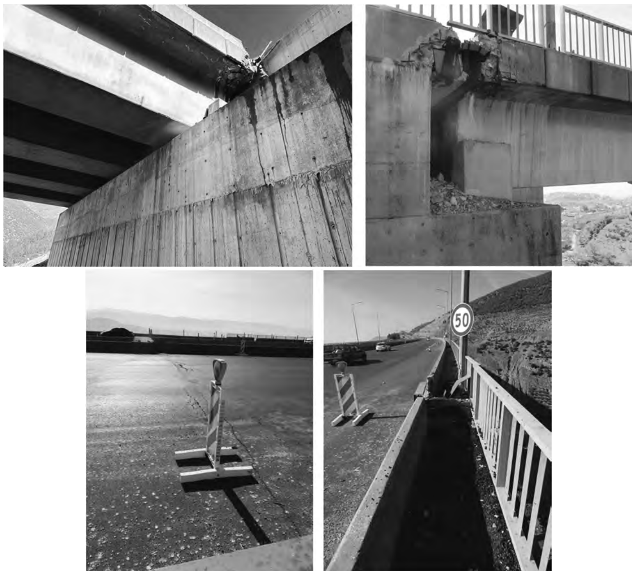
図 5－35 観察された損傷の例
