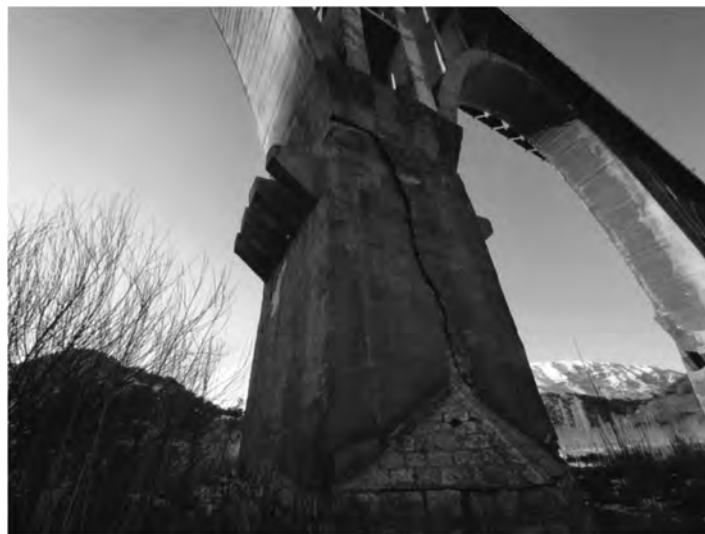
図 3－63 鉄道橋の被災例
