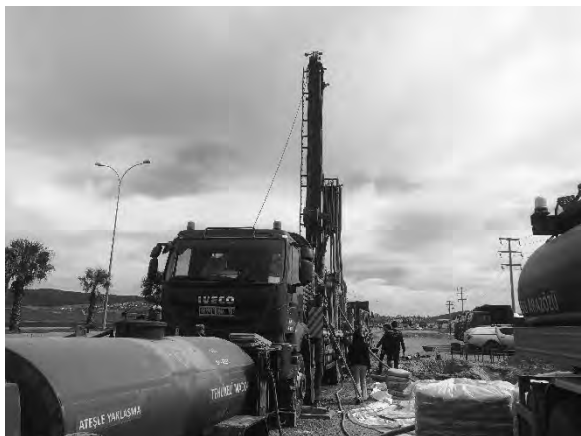
コンテナ村用の井戸掘削
