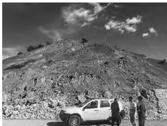
(b) 強風化部の崩壊
