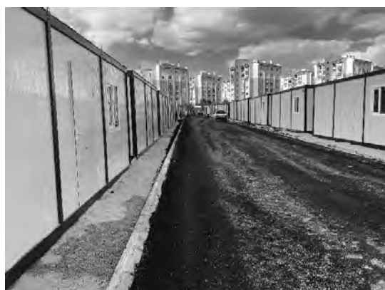
(a) 仮設住宅と損傷が小さい高層住宅
