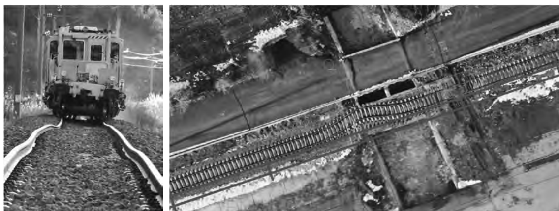
図 3－60 軌道・レールに生じた変形の例
