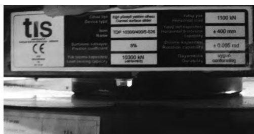
(a) 免震装置銘板
