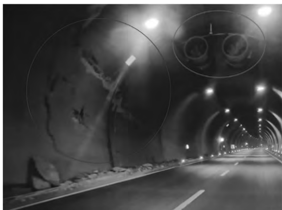
図 3-48 エルゲネクトンネルの損傷状態
