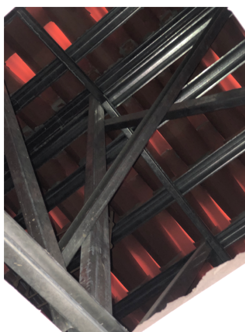
写真：新築中の鉄骨屋根小屋組
