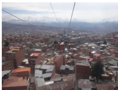
ラパスには錆びついた金属屋根が多い
