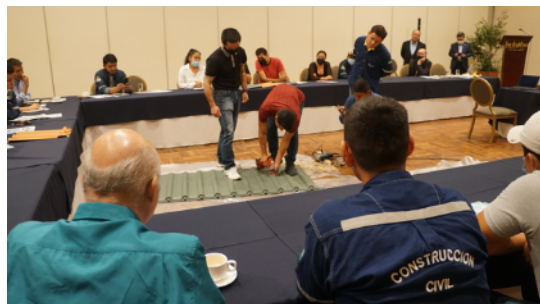
ニブラーで金属屋根を切断する実習
