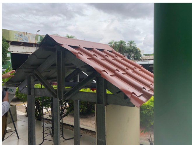
写真：鉄骨屋根小屋組のサンプル
