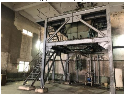
Bac Thang Long 下水処理場視察 於：ハノイ市
