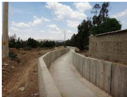
Componente 2 (Lado de aguas abajo desde el punto de inspección)
