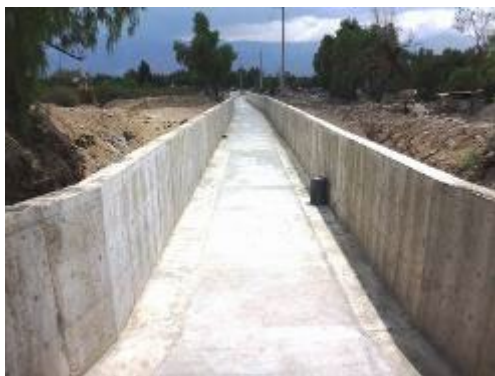
Componente 1 (Lado de aguas arriba desde el punto de inspección)
