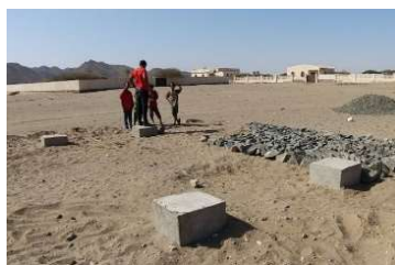
図 6-57 コンテナ据付用のコンクリート基礎
