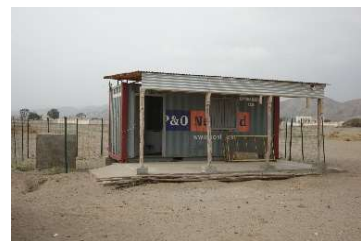
図 6-59 底を付けコンクリートを打設し作業場となった CFC の正面
