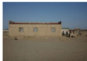
図 6-56 屋根の葺き替えと塗装、後側の外壁に 3 窓新設
