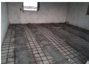
図 6-54 製氷機室床の鉄筋コンクリートを打設中
