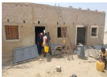
図 6-55 窓とドアの修復・拡張
