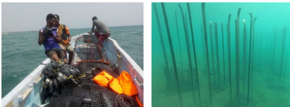
図 6-74 シーラント設置作業と海底に設置された状況
