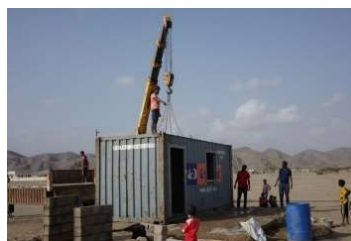
図 6-58 MMR 技術局スタッフにより改造されたコンテナの据付
