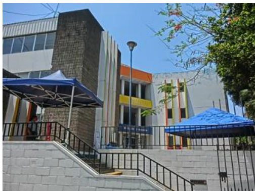
写真 1：サントアナ教員研修センター（本館）。本建屋 1 階に本プロジェクトによる機材配置室予定の各室 Room1 及び Room2 を擁する。
