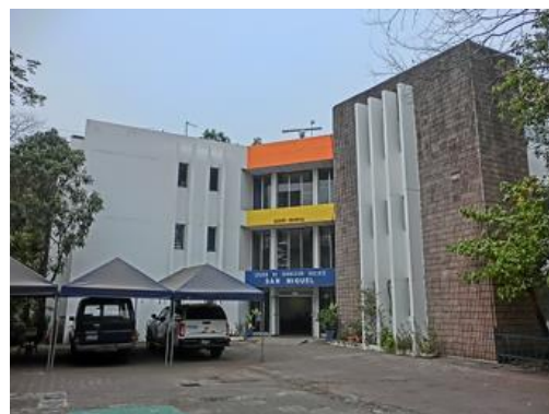
写真 4：サンミゲル教員研修センター（本館）。本建屋 1 階に本プロジェクトによる機材配置室予定の各室 Room1 及び Room2 を擁する。
