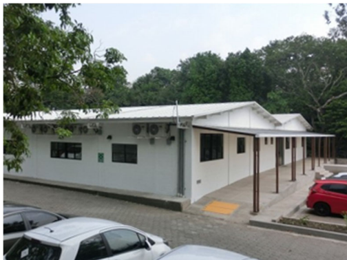
写真 3: セントラルフォーラム（新築棟）。本プロジェクトの機材配置場所となる。ほぼ完成し一部スタジオは試験運用が開始されている。
