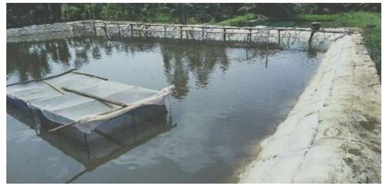
(1) 池壁の補強作業手順 (2) 土嚢で池壁を補強した養殖池
