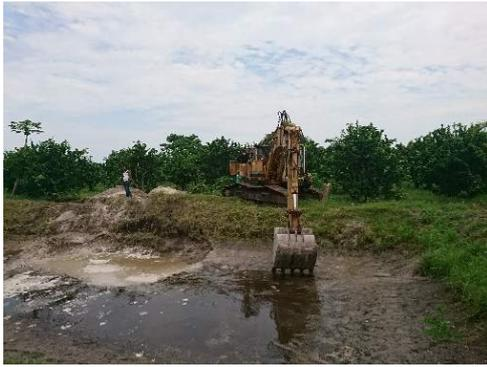
図 5.1.11 重機による養殖池の掘削
