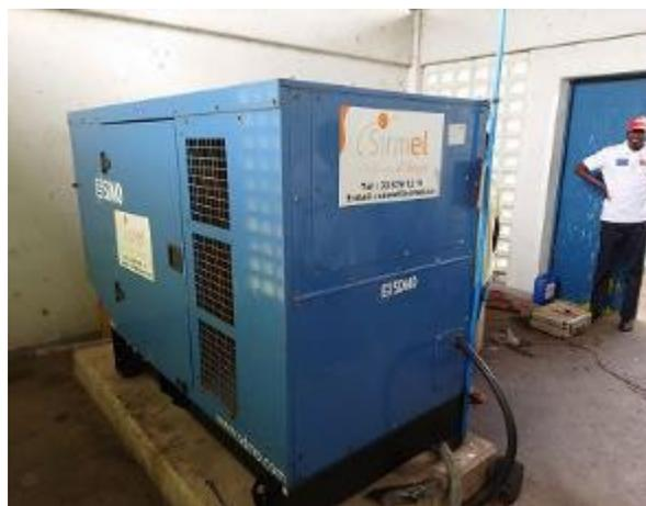
Générateurs diesel pour alimenter la machine à glace
