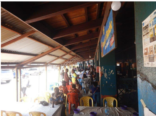
13 : Le toit du restaurant a été agrandi pour installer plus de tables et chaises.
