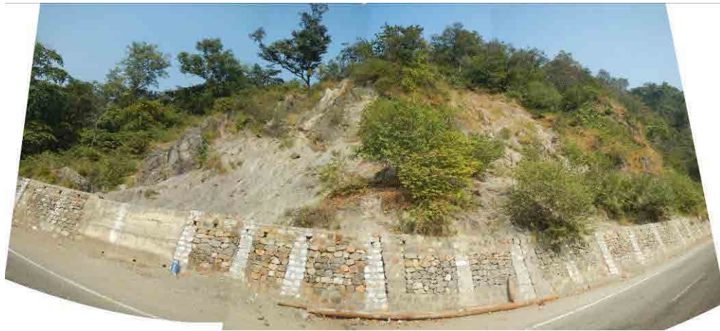
写真 3.3 対象斜面状況(左側:No.1斜面、右側:No.2斜面)
