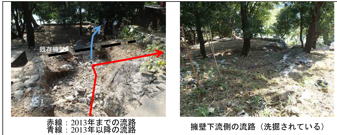
写真 3.2 下流側流路の状況
