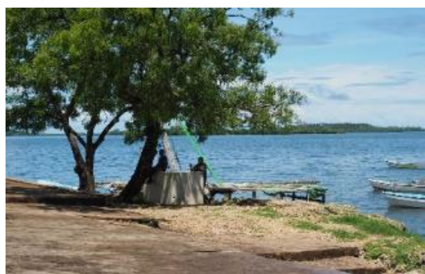
図 4-22 陸側のコンクリート床
