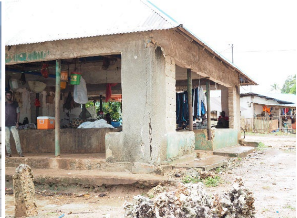
図 4-18 既存のオークション棟
