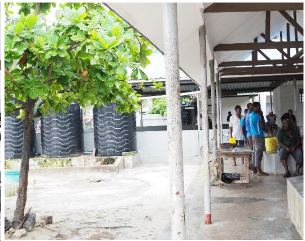
図 4-6 左に雨水貯水タンク
