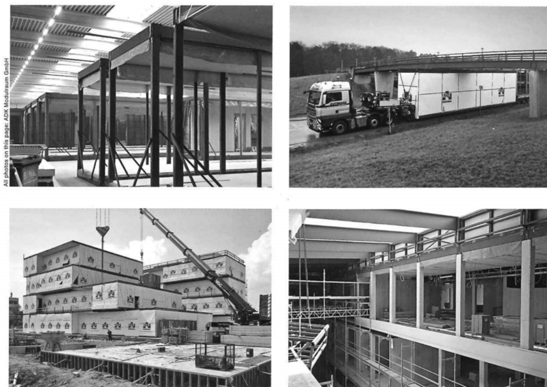
出典：“Detail 6.2020（ドイツの建築雑誌）”より、モジュラー構法を使った製作工程
