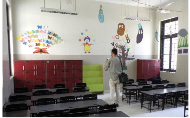
同左: 就学前教室 (ECE) 内部。天井高約 3.7m と高く設定し、大きな窓を設けることで明るい空間となっている。
