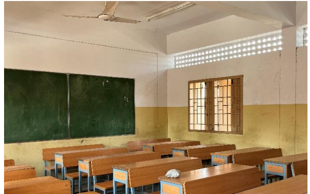
同左: 中等学校教室内部。
