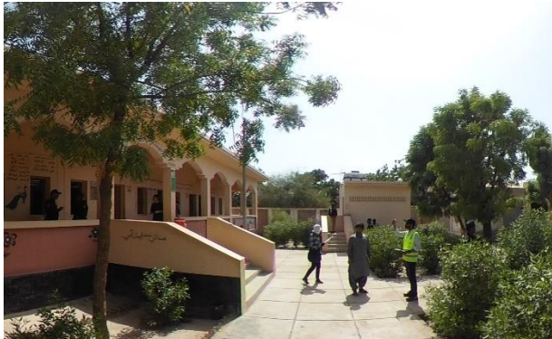
Na03 GGES Jalalani:協力された中学校校舎外観。建物本体に損傷は見られない。
