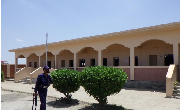
Ba06 GGES Ibrahim Chandio: 協力された中等学校校舎外観。建物本体に損傷は見られない。
