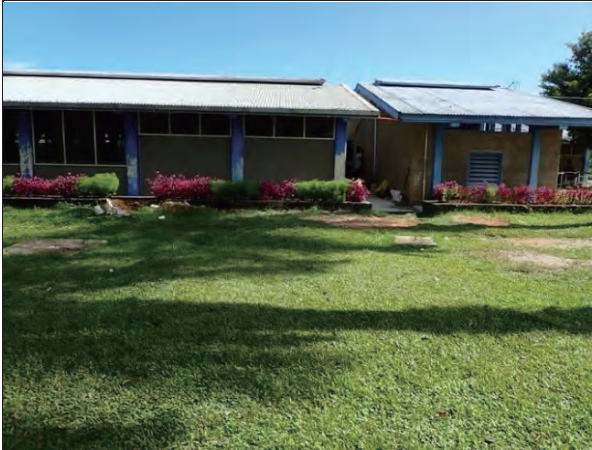
既存施設：産科病棟と既存電気室（本事業で撤去、電気設備工事により復旧）
