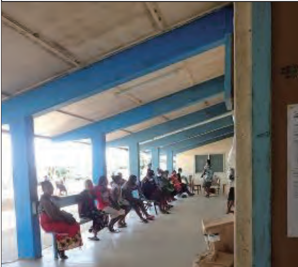
既存施設：外来診療棟の半屋外待合スペース。プライバシーが必要な産婦人科患者も同じスペースで待つなどの課題がある。
