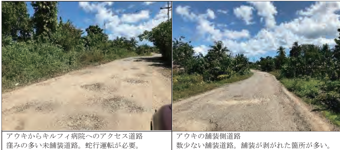
図 2-3 本建設予定地周辺の道路状況
