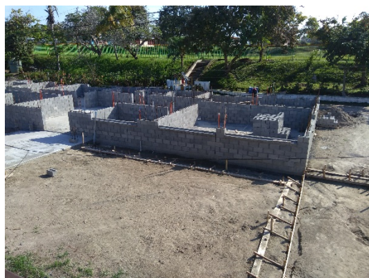
建設中のアドミ棟 (PIP の支援)
