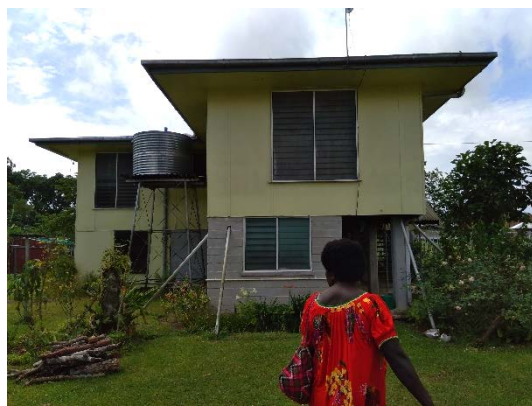
教員住宅外観
