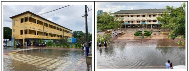
教室棟④ 外観
