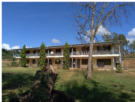
2階建て教室棟 (2016年建設)
