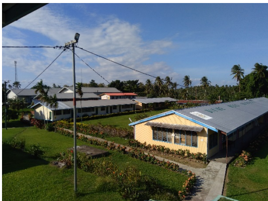
教室棟外観 (手前は古い教室棟)
