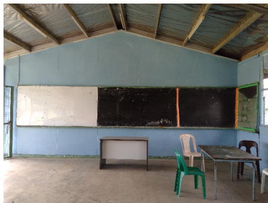
教室内観 (1970年建設)
