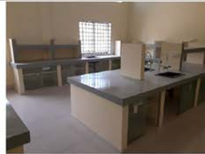
②SRC 理科実験室（改装中）
