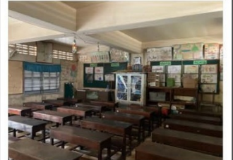
教室棟① 教室内部
