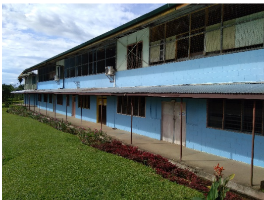
2階建て教室棟外観 (1970年建設)
