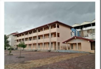
教室棟② (コミ開無償で建設)
