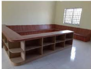
⑤SRC 図書室（改装中）
