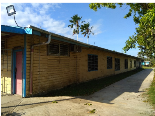
女子寮外観 (フェンス無し)
