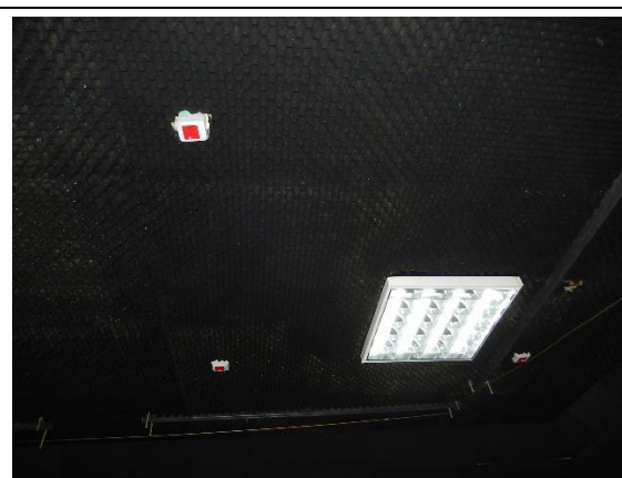
天井に設置されている電源プラグ
