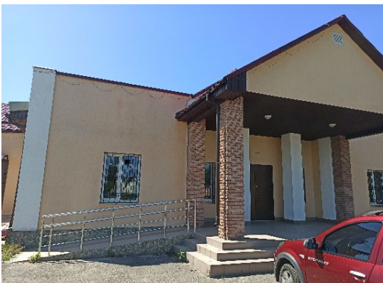
写真 5：DLC が設置されているキエフ州の公共文化施設の外観。
