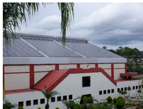
大学敷地内の建物の屋根にはソーラーパネルが敷き詰められている。(写真：体育館)
