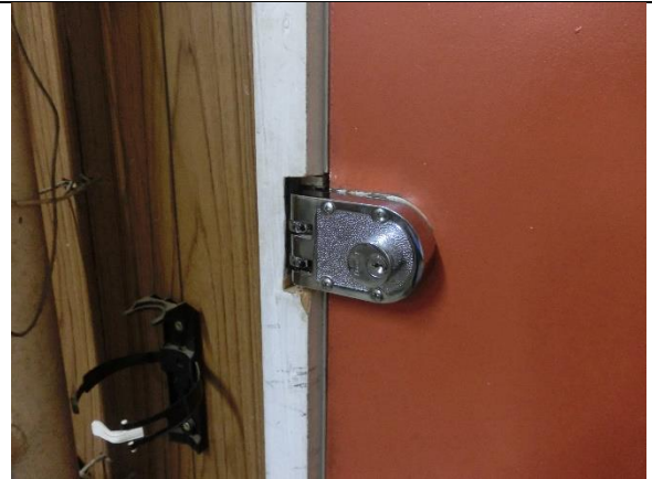
鍵が設置された扉
