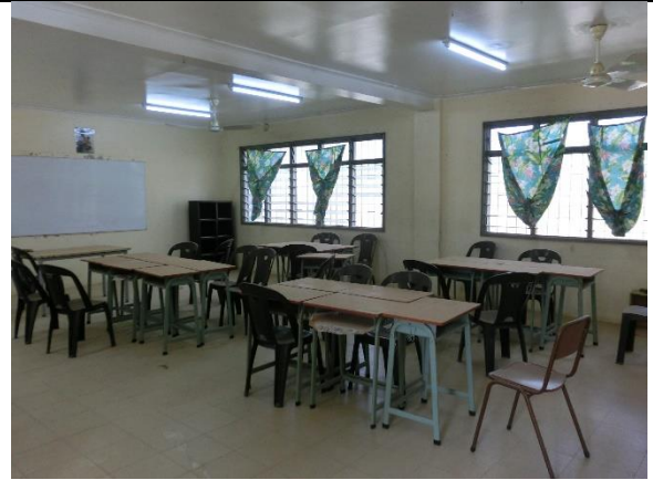
窓の構造上室内には砂塵侵入多し
