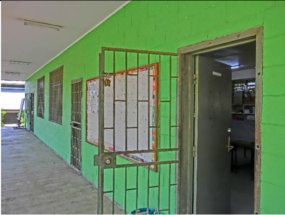
鉄格子が設置された扉
