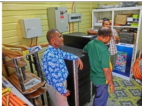
サーバールーム
