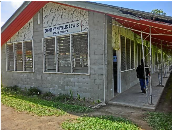
教室建物外観。いずれもルーバー型ガラス窓
