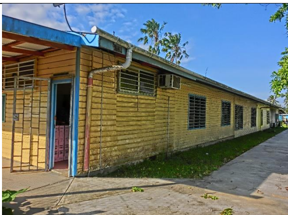
理科実験室建物外観（木造・エアコンなし）
