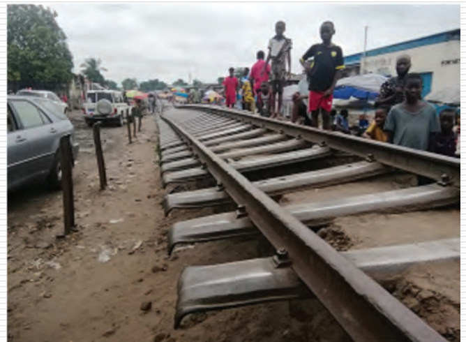
Effondrement de la plate-forme
