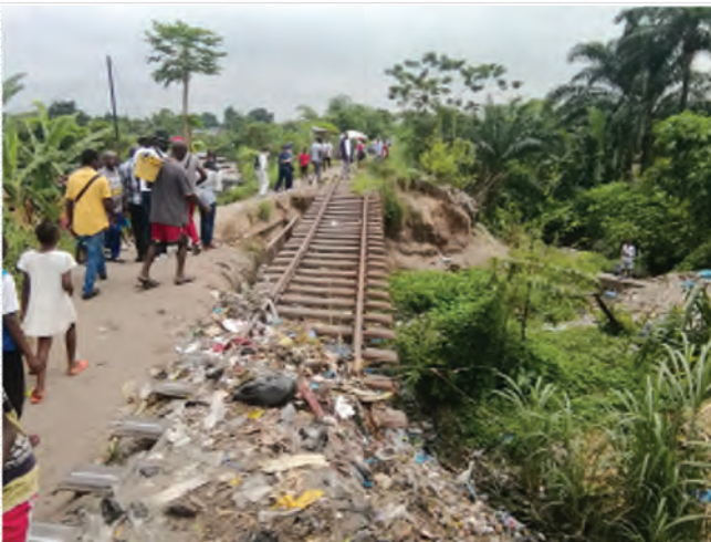
Effondrement important d'un talus
