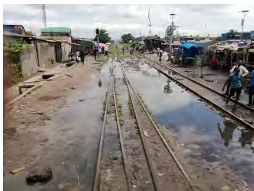
図 4-87 分岐器が滞水している状況
