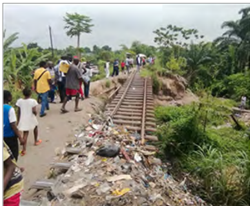
図 4-17 盛土崩壊（Limete 駅から 5k800m 付近）
