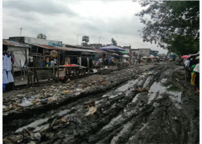
排水不良の地盤に埋没した線路
