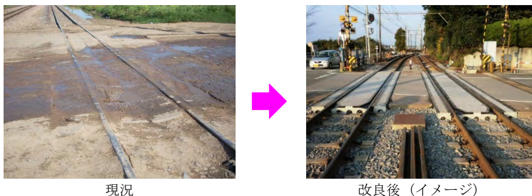
図 5-35 踏切連接軌道概要図
