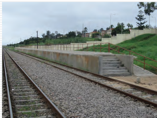
工事中の高床式プラットホームホーム
