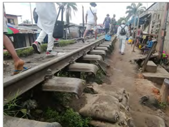
図 4-12 路盤・盛土下が削られた状況 (Limete 駅から約 0.5km)
