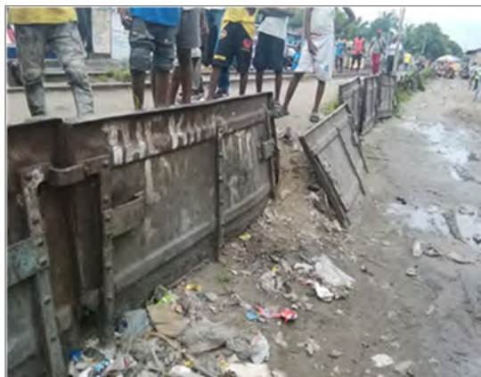
図 4-18 鋼製土留崩壊（Limete 駅から 6k100m 付近）
