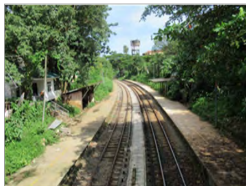
図 4-72 線間の排水路整備後の例（複線）
