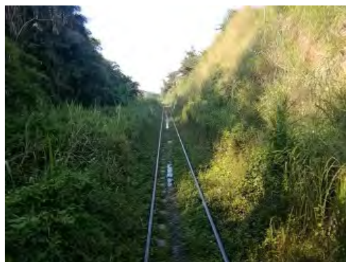
図 4-92 線路に近接した無対策の斜面
