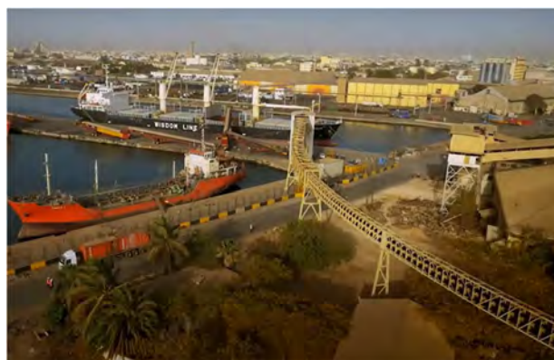
図 7-26 鉱石を荷役設備（ベルトコンベア）で第五埠頭の船舶へ積載している様子
