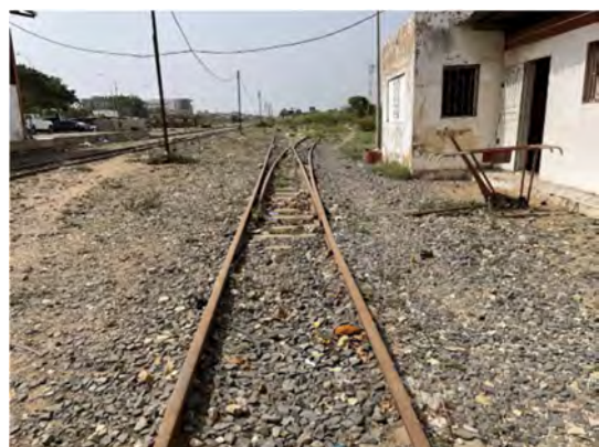
図 7-108 本線から車両修繕設備のある 区画へ分かれる分岐器
