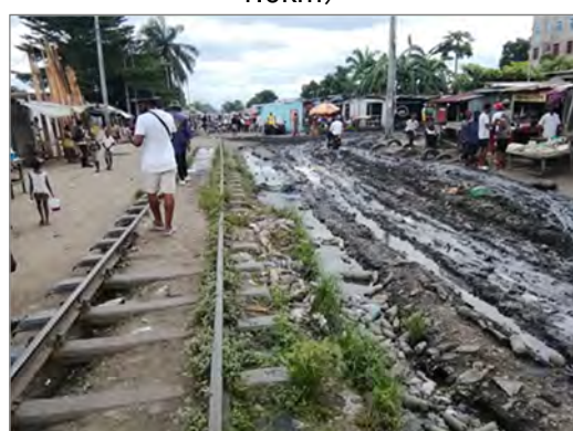
図 4-14 線路埋没部 (Limete 駅から約 1.0km)
