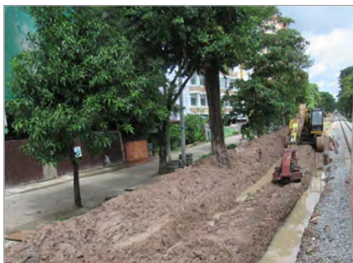
図 4-65 路盤の整備の例
