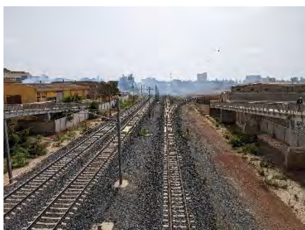
図 7-8 標準軌複線とメーターゲージ単線
