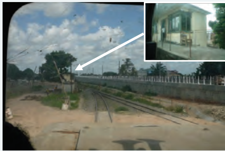
Bungoniに設置されている信号取扱所
