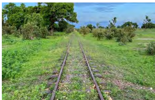
図 7-67 バラストが不足している線路
