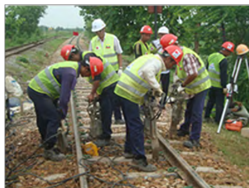
図 4-70 バラストの突き固め例
