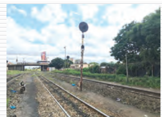
使用されていない電気信号システム
