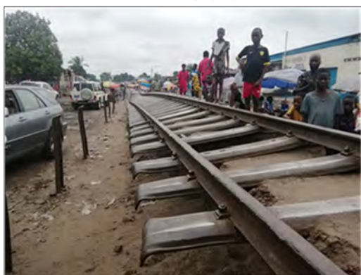
図 4-17 盛土崩壊（Limete 駅から 5k800m 付近）
