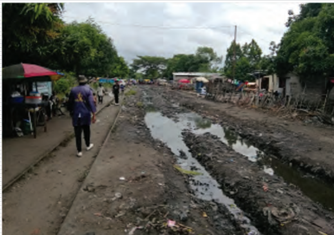
排水不良箇所
